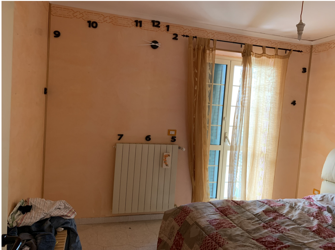
FOTO N.9 Vista interna camera n.02 primo piano
