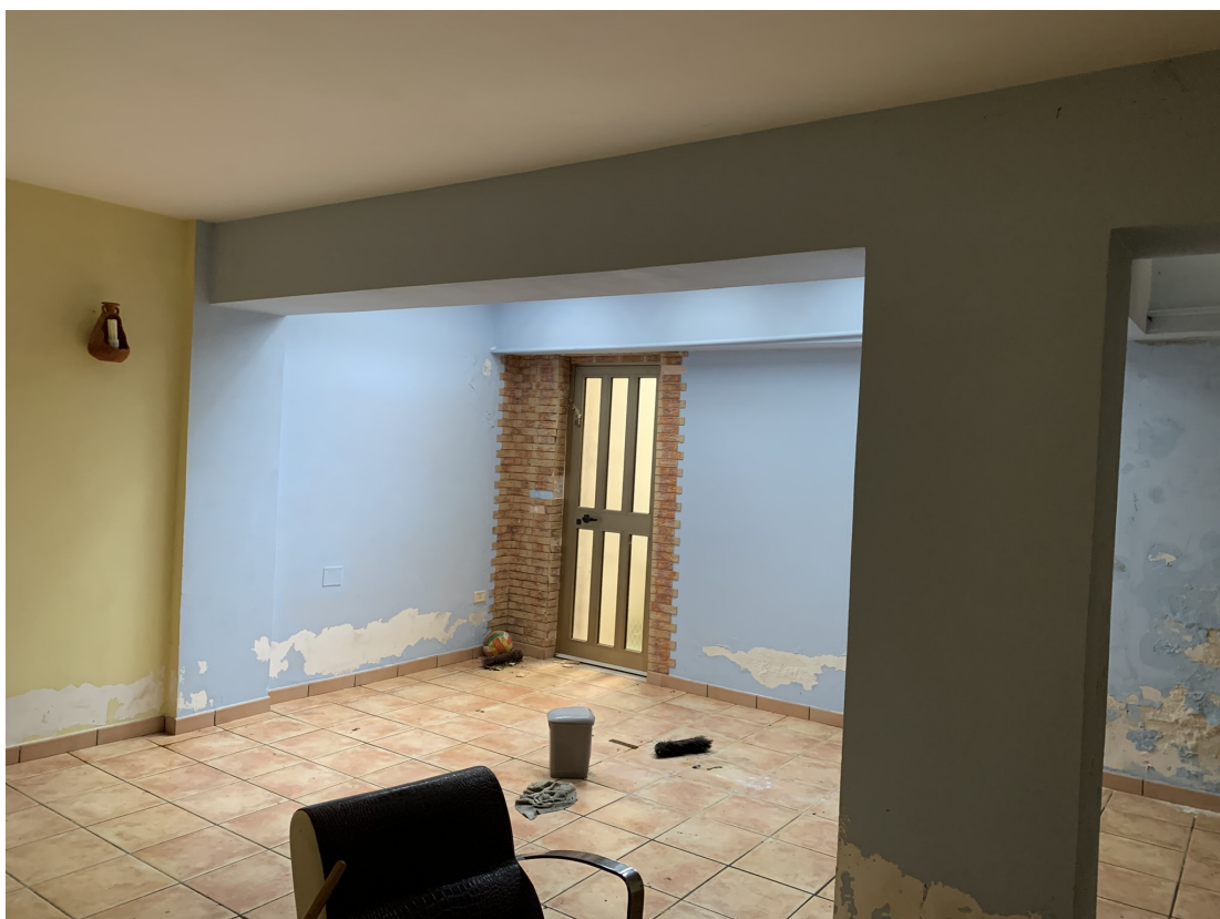
FOTO N.14 Vista interna piano interrato.
