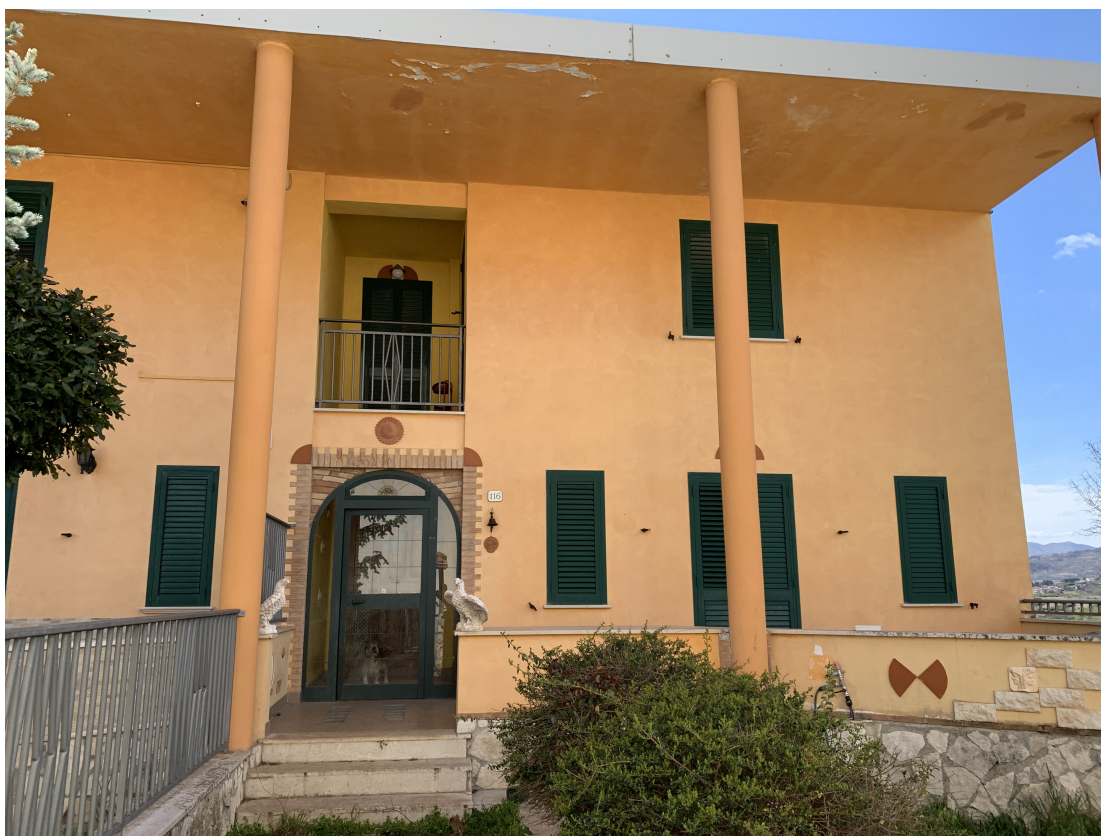
FOTO N.2 Vista esterna lato nord-est.
