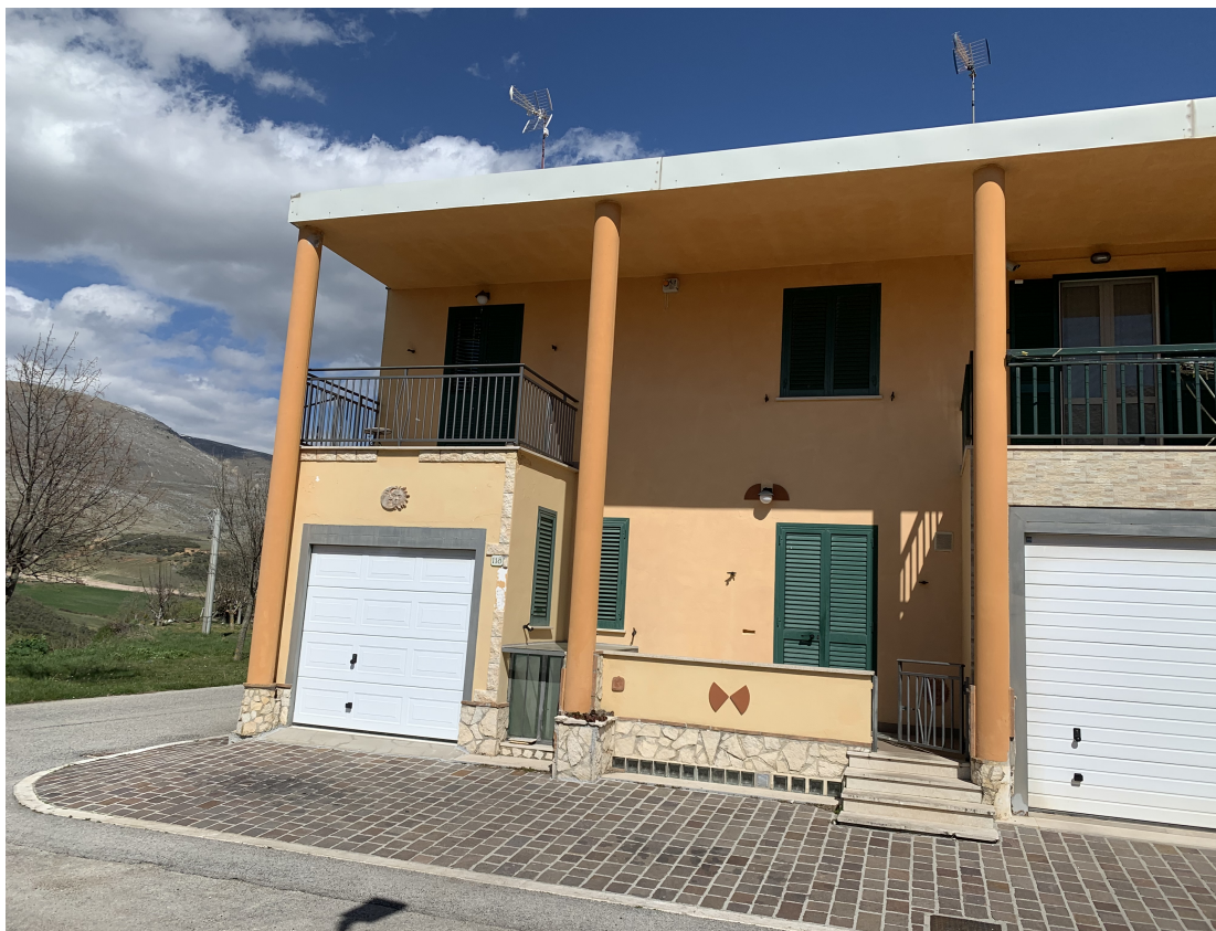
FOTO N.1 Vista esterna lato sud-ovest.
