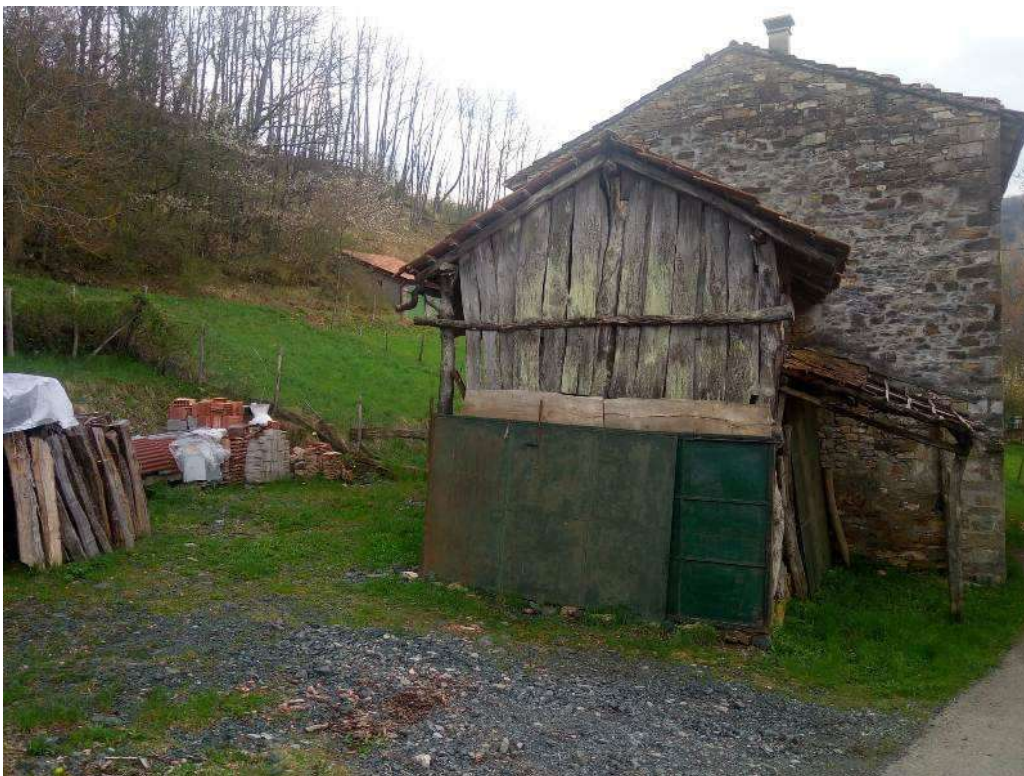
FOTO - vista prospetto nord
