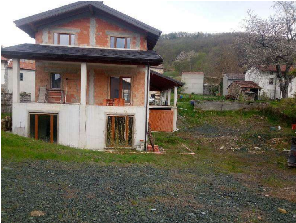
FOTO - vista prospetto ovest
