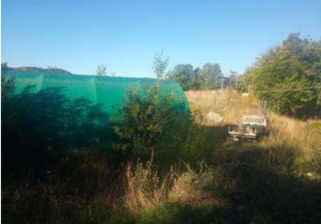
FOTO - vista della costruzione precaria da rimuovere, fg. 46 mapp.225
