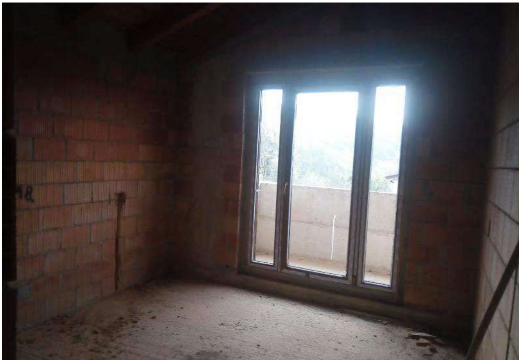
FOTO - vista interno piano primo – camera
