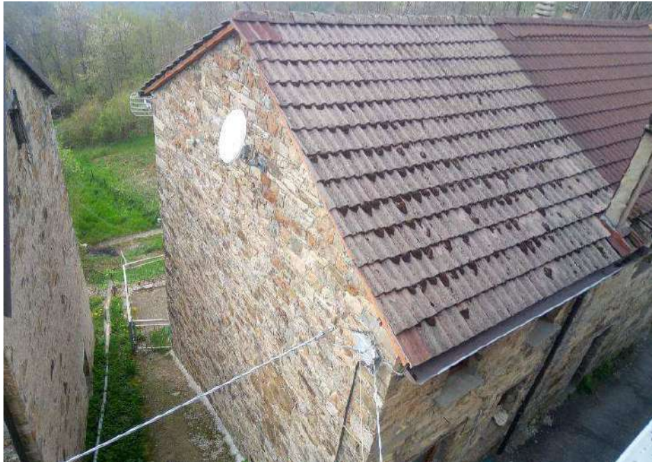
FOTO - vista prospetto nord-ovest
