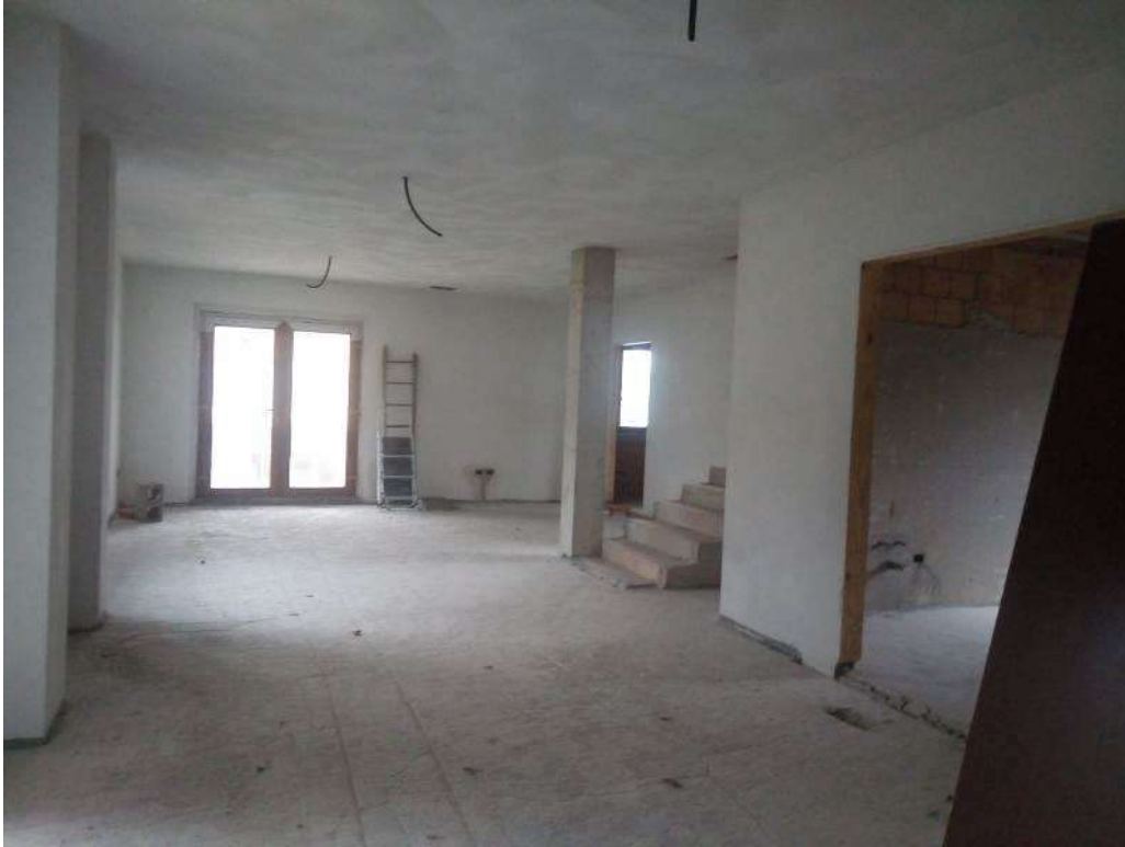
FOTO - vista interno piano terra - sala
