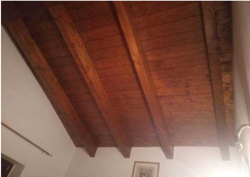
FOTO - vista interno piano secondo - tetto
