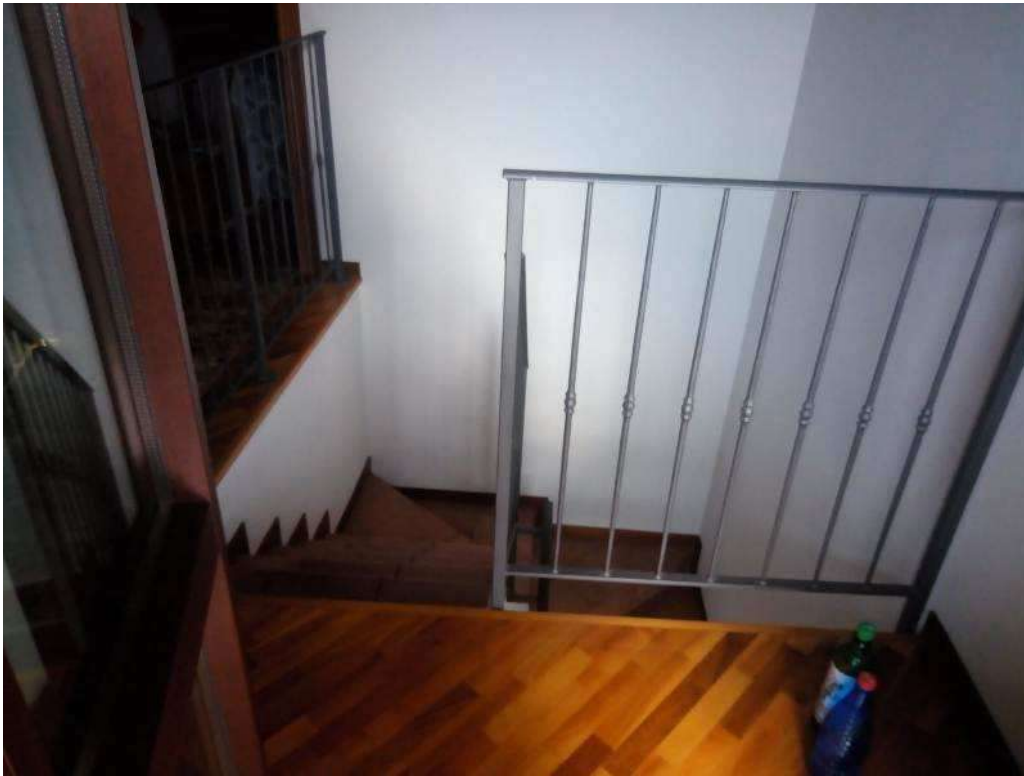
FOTO - vista interno piano secondo – vano scala
