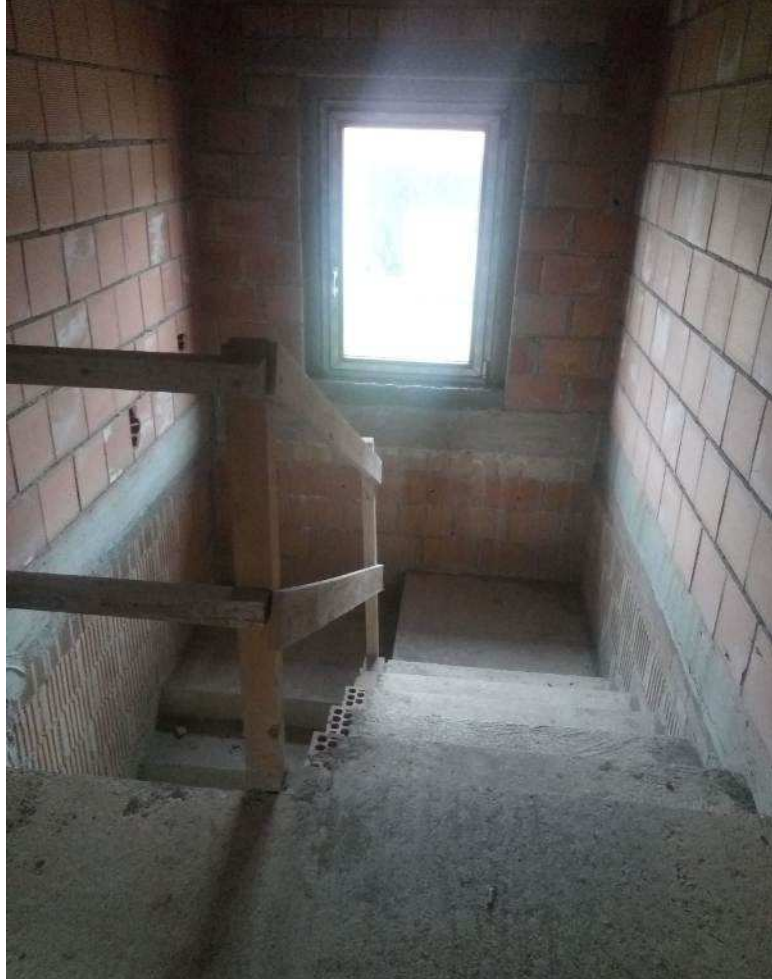
FOTO - vista interno piano primo – vano scala
