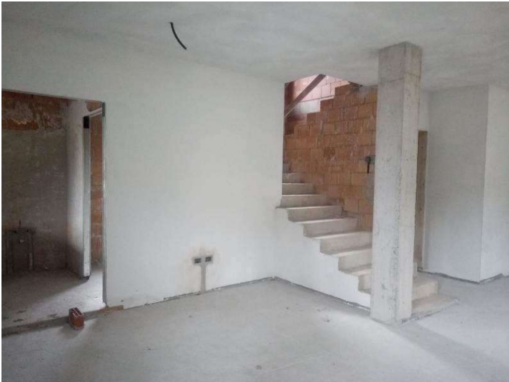
FOTO - vista interno piano terra - sala
