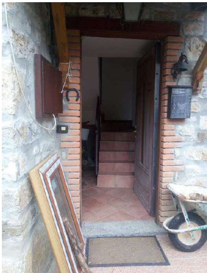
FOTO - vista interno piano primo - ingresso
