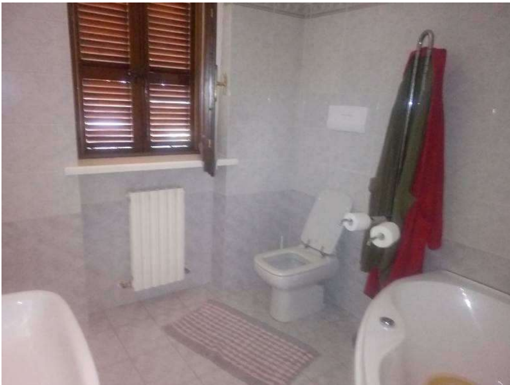
FOTO - vista interno piano primo - bagno
