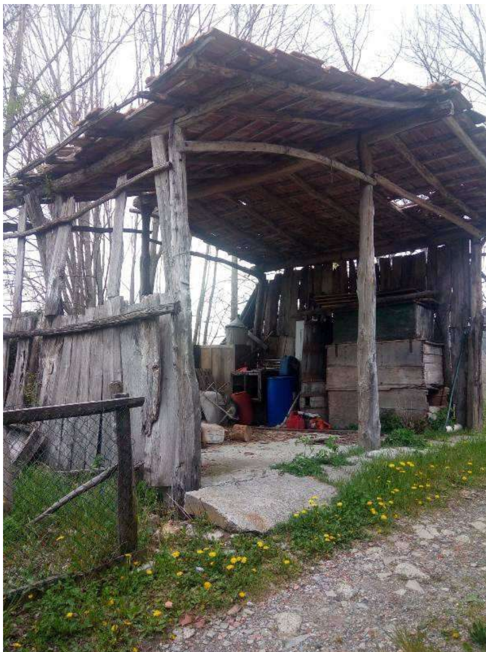
FOTO - vista prospetto sud ed est
