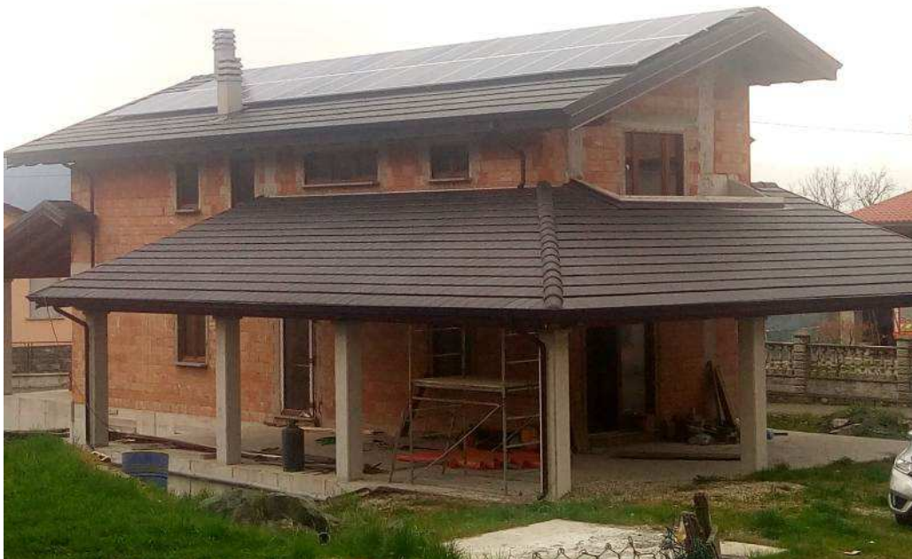
FOTO - vista prospetto sud-est
