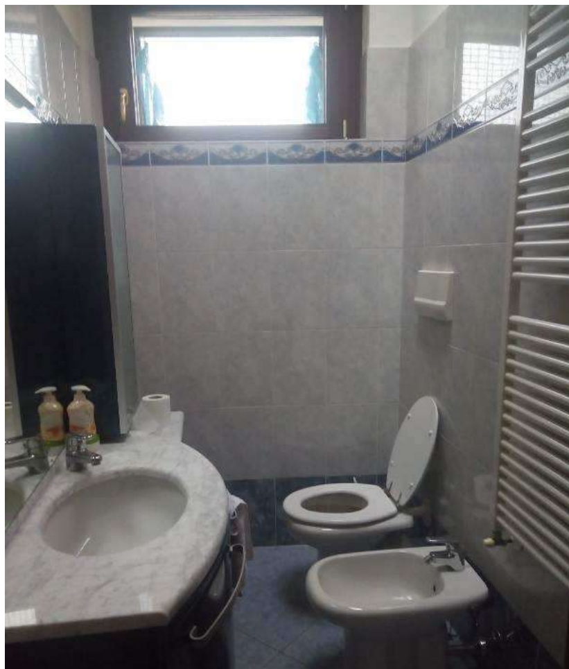
FOTO - vista interno piano secondo - bagno
