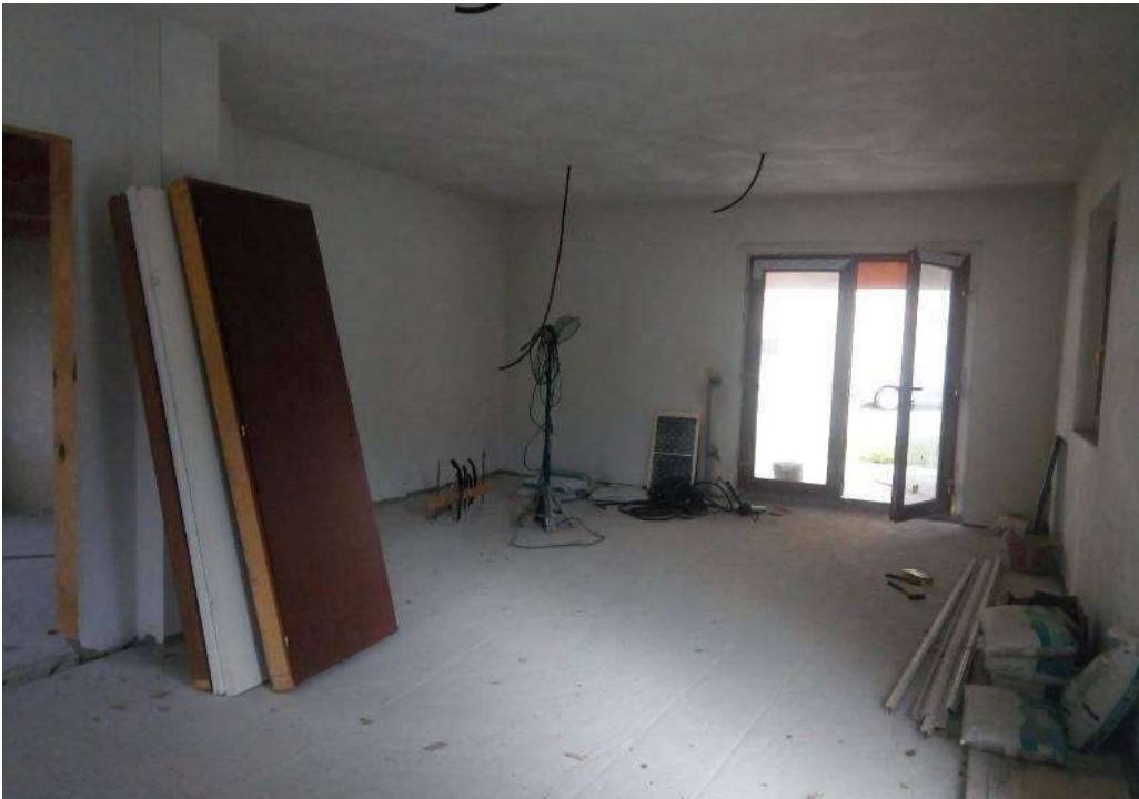
FOTO - vista interno piano terra - sala
