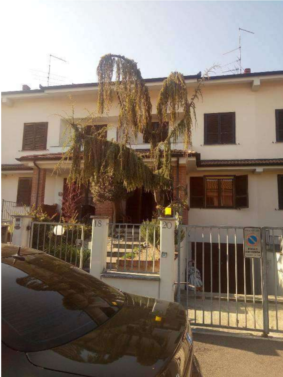
FOTO - vista prospetto nord, ingresso abitazione ed autorimessa
