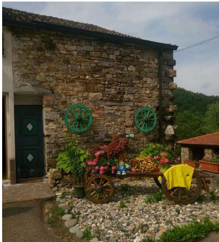
FOTO - vista prospetto nord
