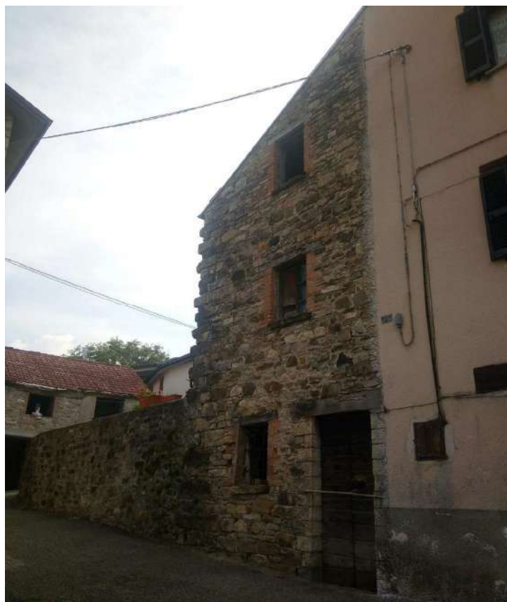
FOTO - vista prospetto ovest
