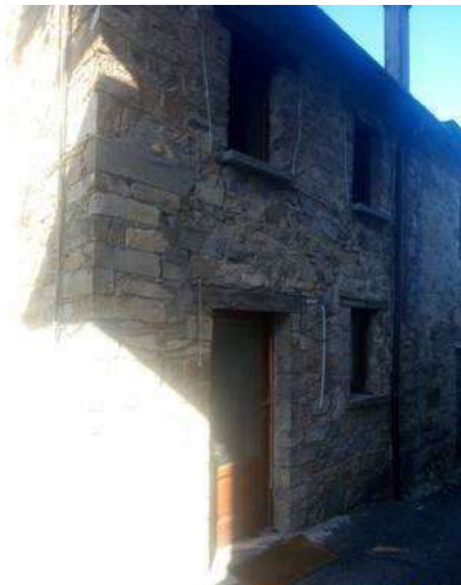
FOTO - vista dell'ingresso (prospetto nord)
