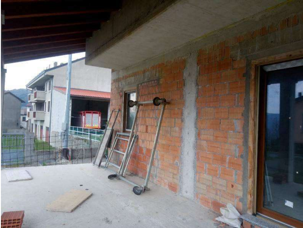
FOTO - vista portico
