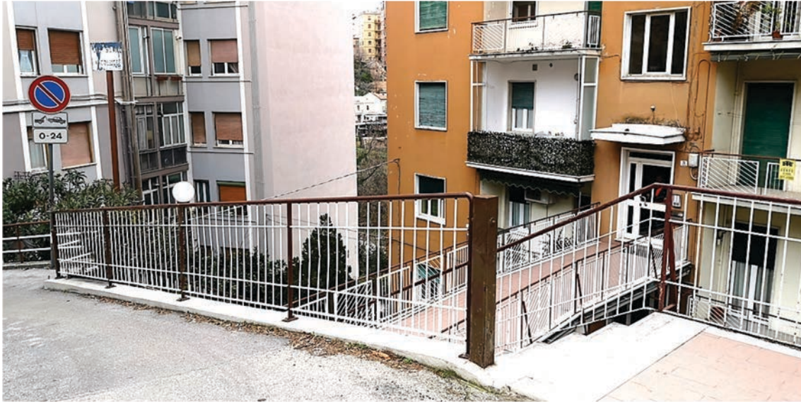
INGRESSO CONDOMINIALE DA VIA PAPA GIOVANNI XXIII
