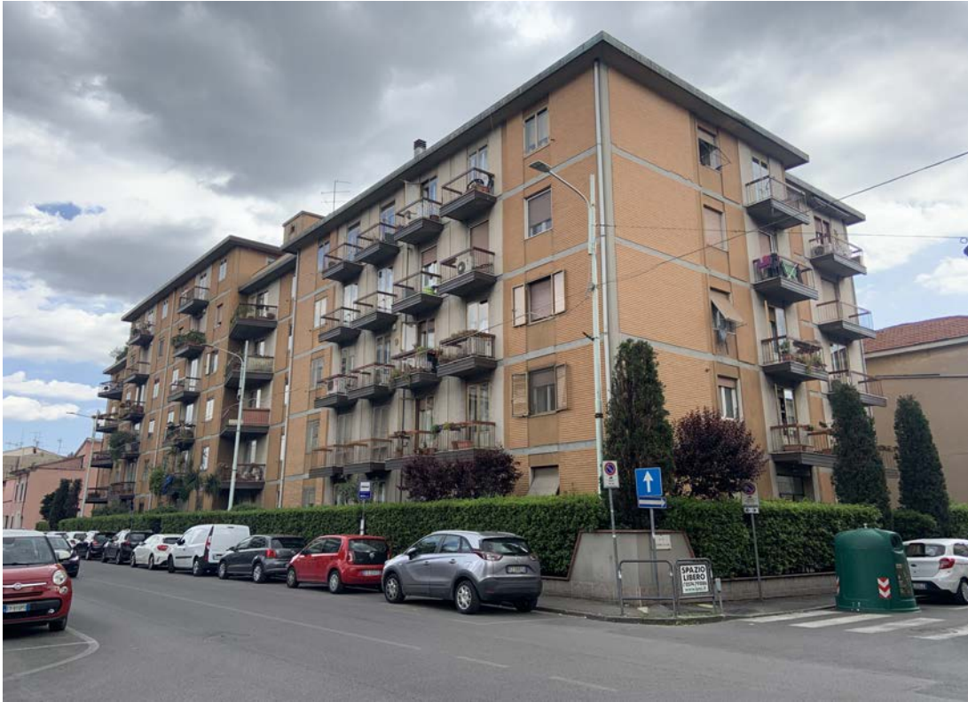
Foto 1 - Vista del complesso condominiale
