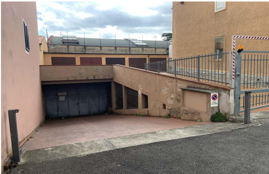
Foto 2 – Ingresso comune da via Zarini
