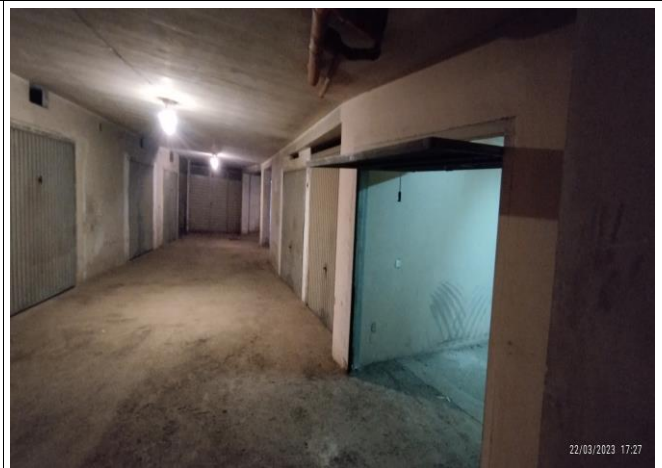
Foto 17 Vista basculante box per identificazione
