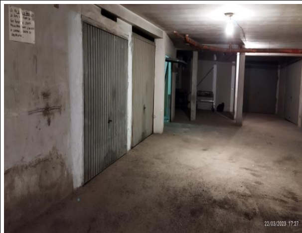
Foto 16 Vista corridoio dei boxes
