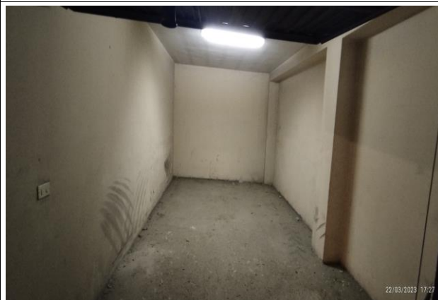
Foto 18 Vista interna del box
