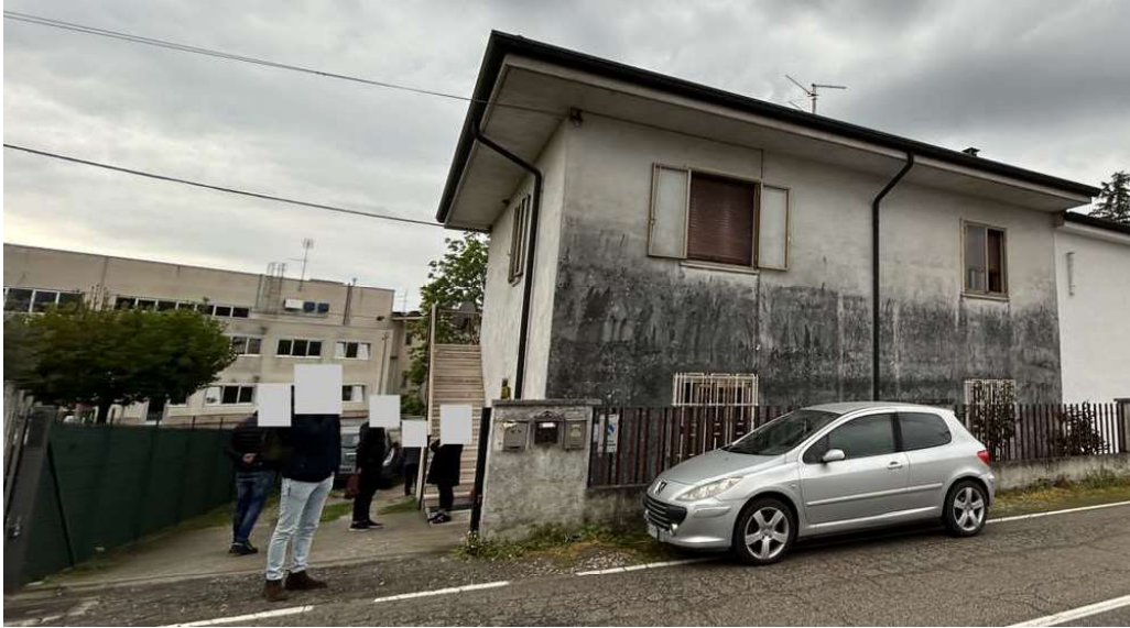
Figura 2: esterni e accesso carraio dalla pubblica via
