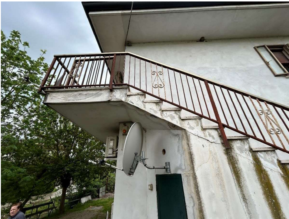
Figura 5: dettaglio scala di accesso
