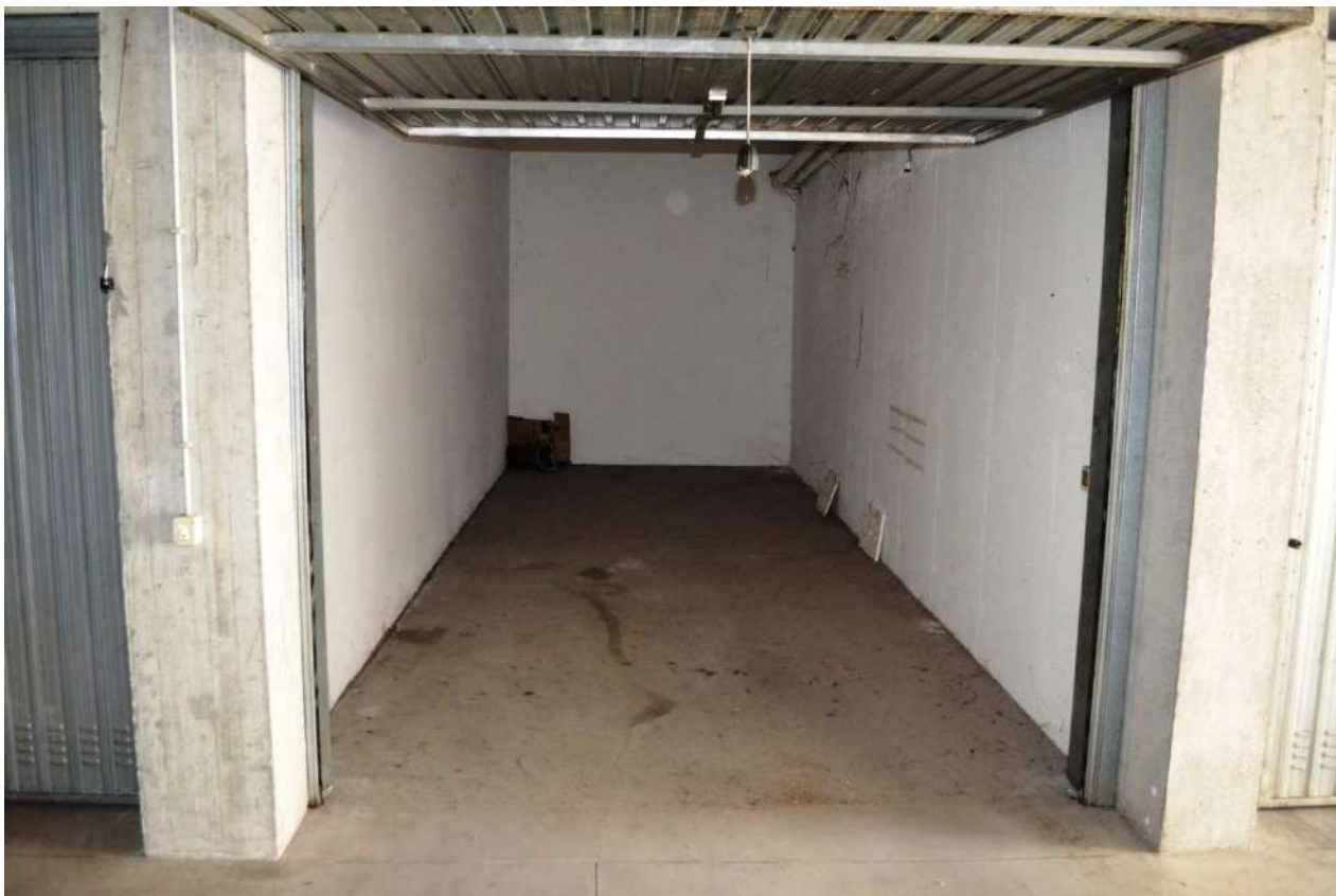
foto 42 – appartamento m.n. 1167 sub 3 - AUTORIMESSA m.n. 1167 sub 9, piano scantinato - l'autorimessa dell'appartamento oggetto di stima a piano scantinato ha dimensioni di m 2,74x7,25 con pavimentazione in cemento liscio ed è accessibile dal vano scala condominiale con ascensore (foto 76), con rampa d'accesso carraio lungo il confine nord del lotto (foto 66)
