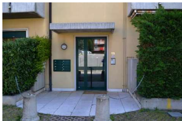
foto 37 - particolare dell'ingresso condominiale al civ. 1/C della derivazione di via Vicenza
