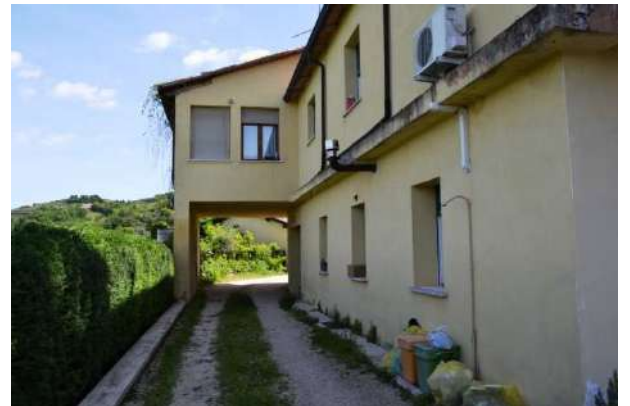
foto 24 - scorcio del prospetto ovest della casa colonica col vialetto d'ingresso della villa
