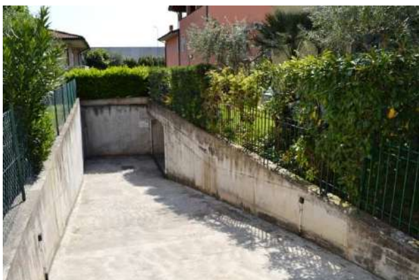
foto 36 - vista dal cancello d'accesso carraio sulla recinzione ovest della rampa del garage
