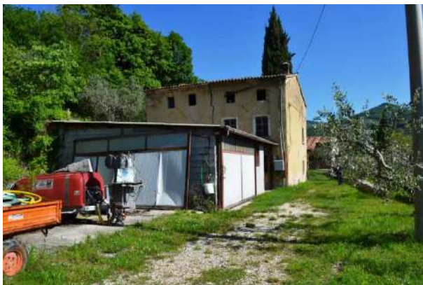
foto 26 - vista da sud della tettoia e del rustico collabente sui m.n. 102/104
