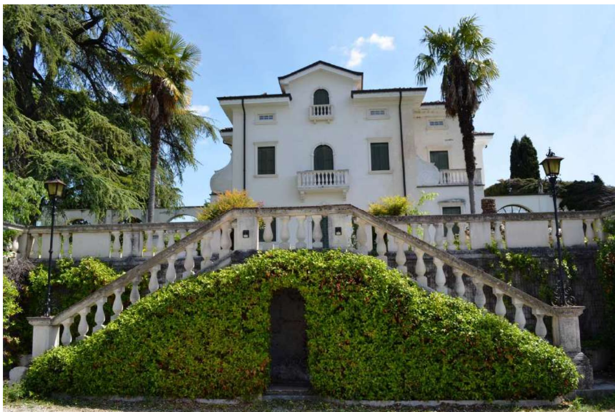
foto 1 – villa con dipendenze, parco e oliveto, VILLA (vista da ovest sul vialetto interno) - la facciata della villa ristrutturata in stile '700 su tre piani f.t. con 9 stanze con accessori e pertinenze, con casa colonica e magazzino e con parco e oliveto recintati di m 2 27.529 catastali in fregio a via Zanella con ingresso al civ. 19 a Colognola ai Colli, è rivolta verso ovest in sommità della collina
