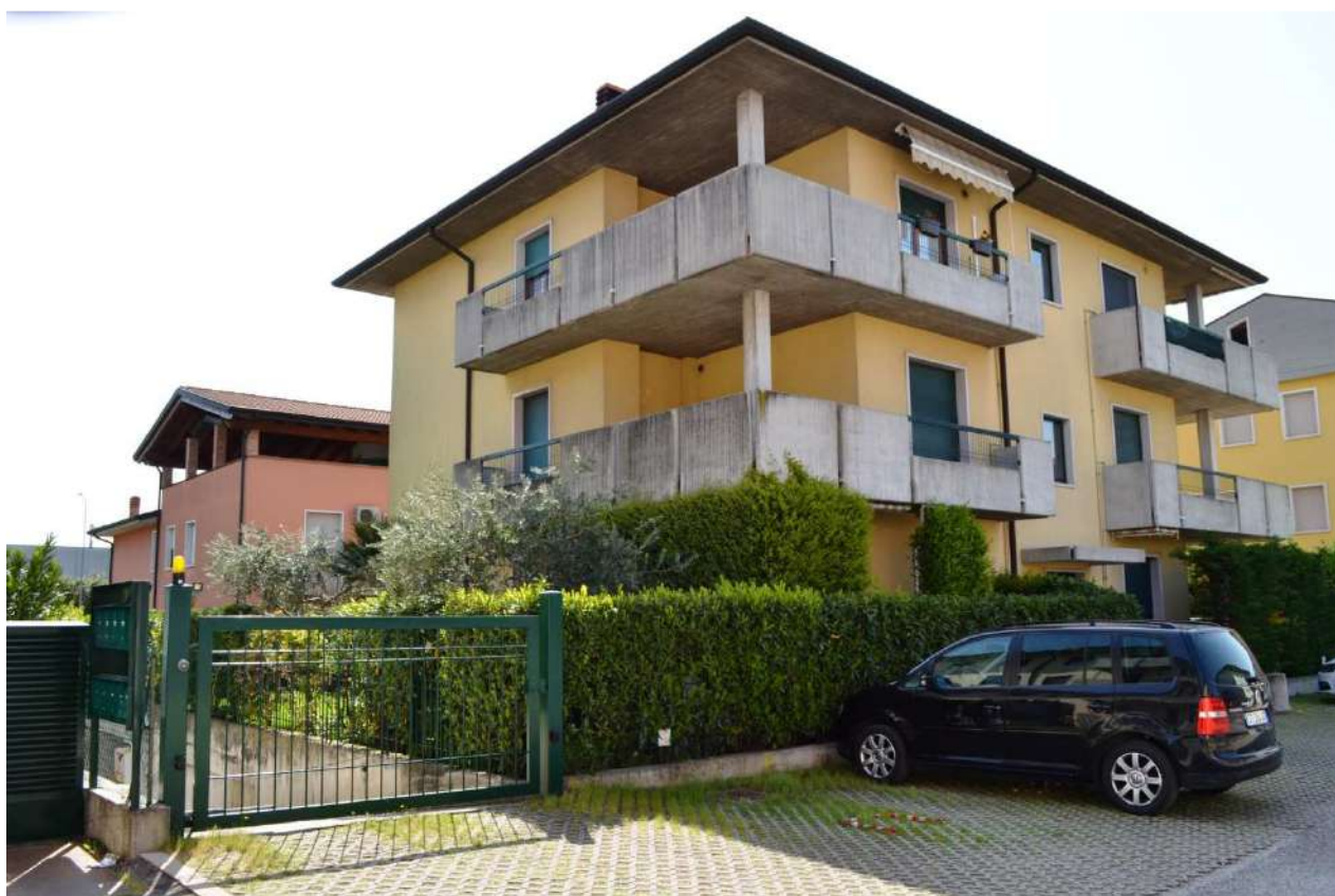
foto 32 – condominio la Primula , APPARTAMENTO a piano 1° (visto da nord ovest) - l'appartamento oggetto di stima occupa la parte nord per il piano 1° con autorimessa a piano scatinato di un edificio condominiale a 3 piani f.t. su una derivazione stradale a nord della via Vicenza (dorsale est di Caldiero); nella foto si vede la terrazza con le porte del letto 2 a nord e del soggiorno a ovest
