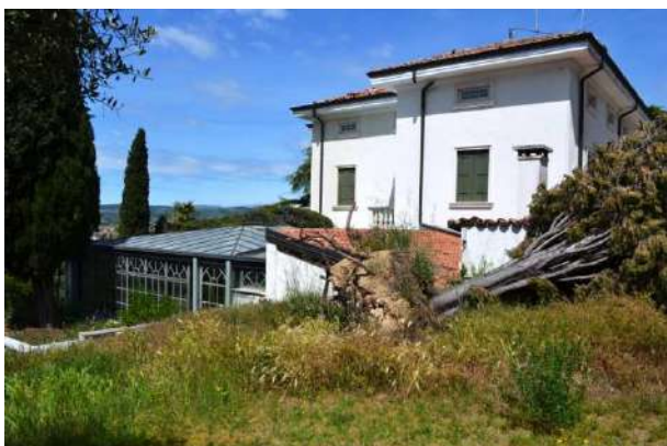
foto 5 - vista da sud est del prospetto sud con randa a sud ovest (plateatico)
