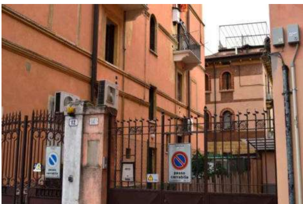
foto 3 - prospetto sud visto da piazza I. Nogarola con la finestra della segreteria a destra
