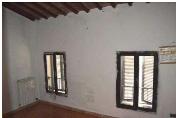
foto 29 - scorcio della stanza fronte strada con le due finestre su via Unità d'Italia
