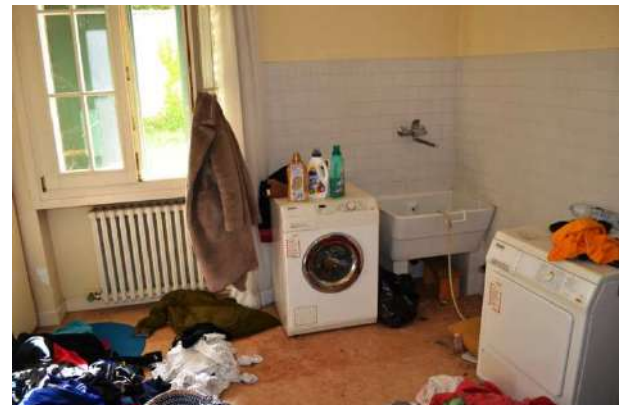
foto 11 - scorcio della lavanderia vicino al bagno a piano terra con finestra sul cortile a est
