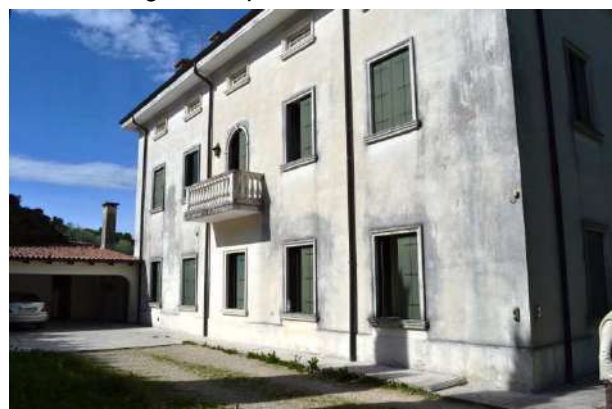
foto 4 - prospetto est sul cortile interno: si vede a sinistra l'autorimessa non autorizzata
