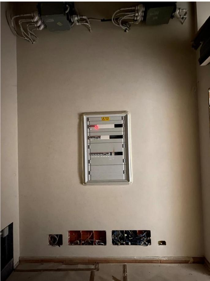
**Foto 38 – Piano Primo – quadro elettrico di piano all'interno del vano adiacente il bagno**
