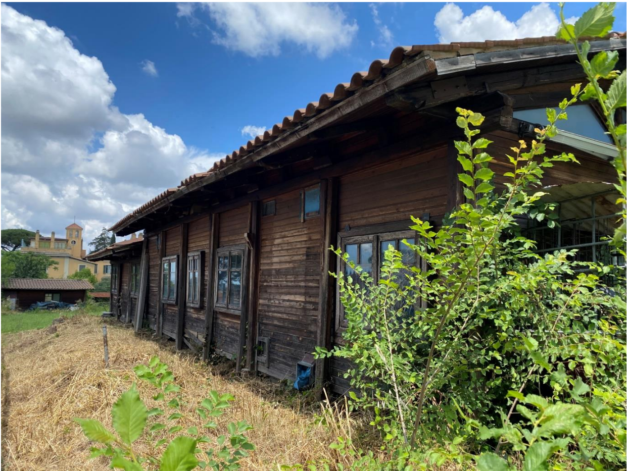
Foto n. 69 – Piano terra – Vista del prospetto posteriore
