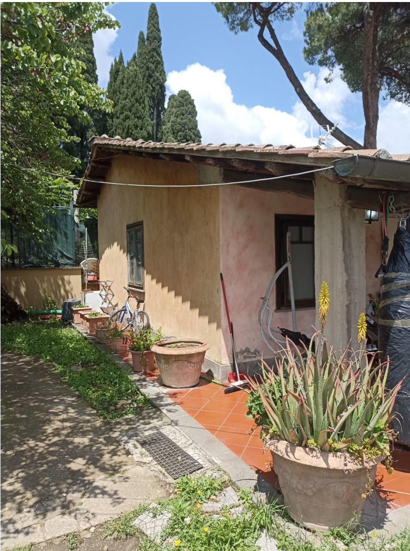
Foto n. 74 – Vista della casa del custode lato sud-ovest
