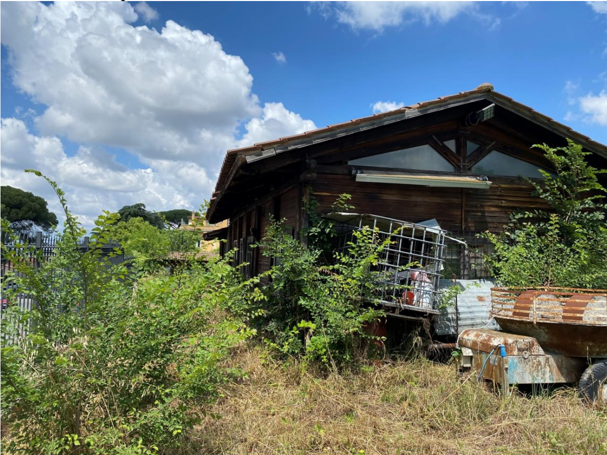
Foto n. 68 – Piano terra - Vista del prospetto laterale
