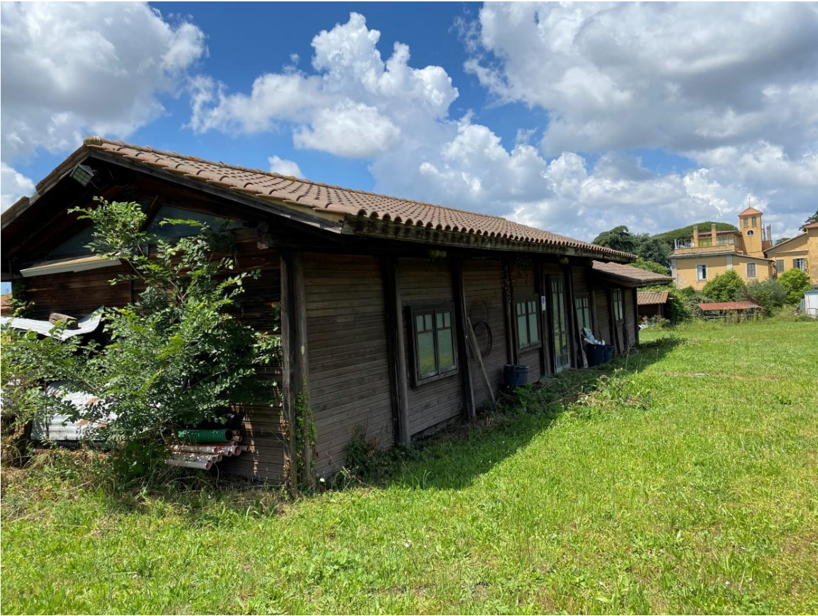
Foto n. 67 – Piano terra - vista del prospetto principale dell'edificio adibito ad ufficio dove è ubicata la porta di accesso.
