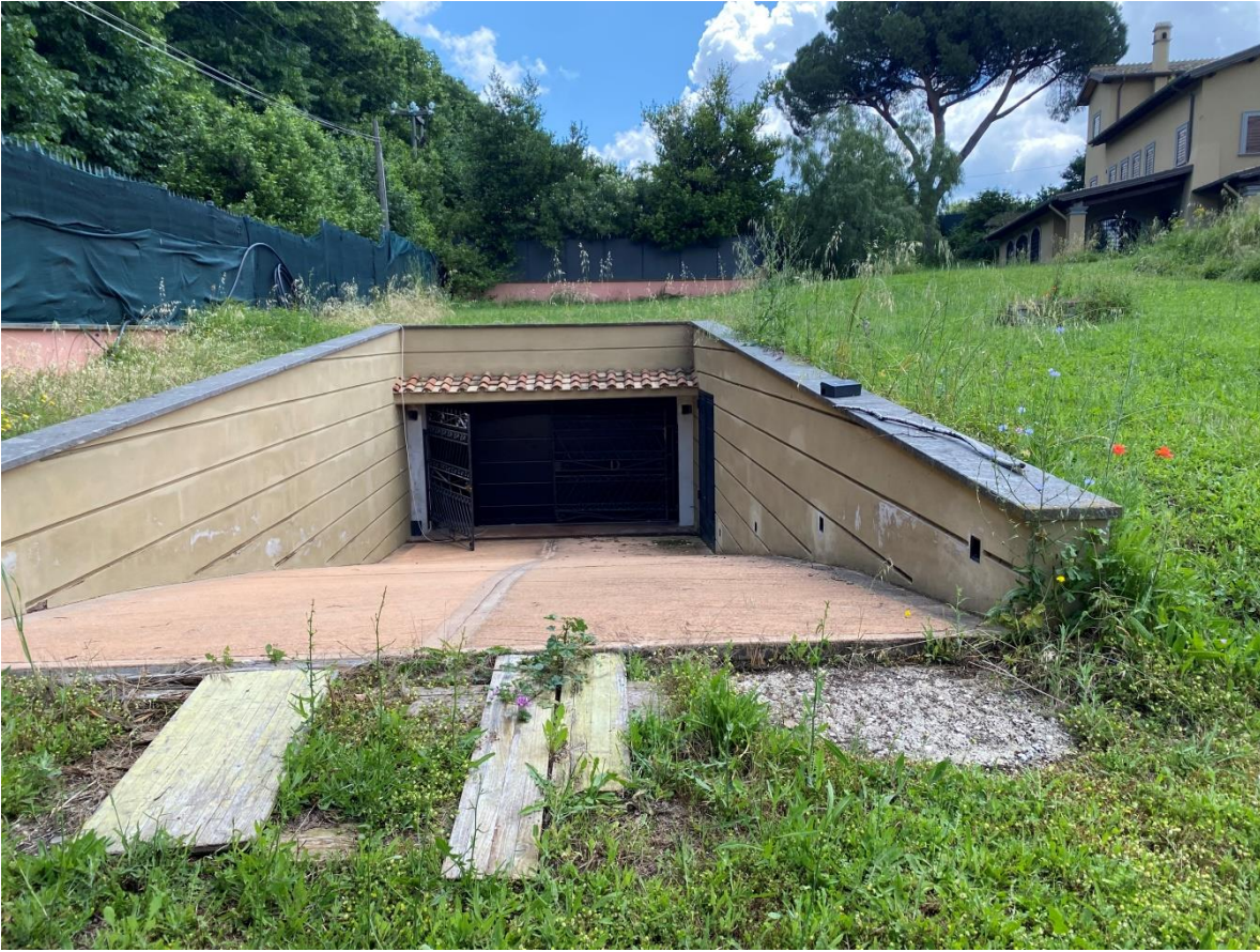
Foto n. 53 – Piano interrato – Rampa di accesso al piano interrato
