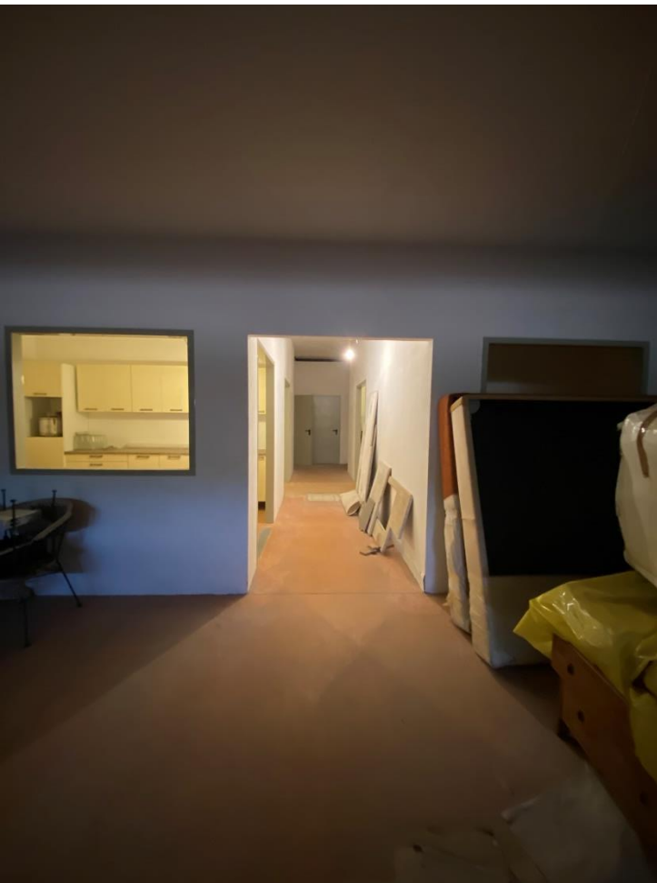
Foto n. 56 – Piano interrato – Vista del disimpegno in fondo che porta ai vari locali
