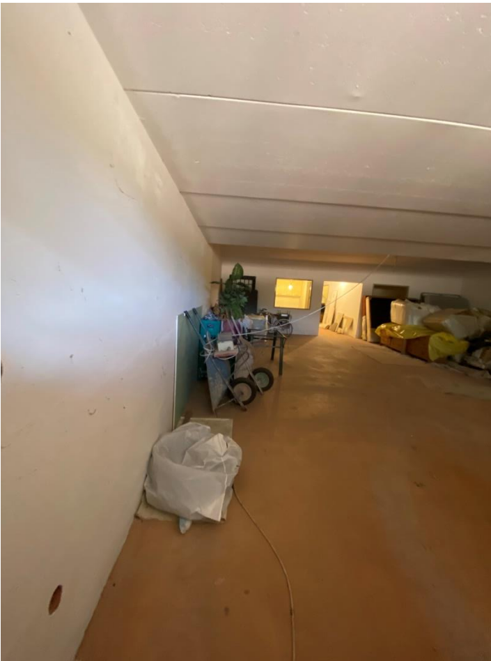
Foto n. 55 – Piano interrato vista del vano principale
