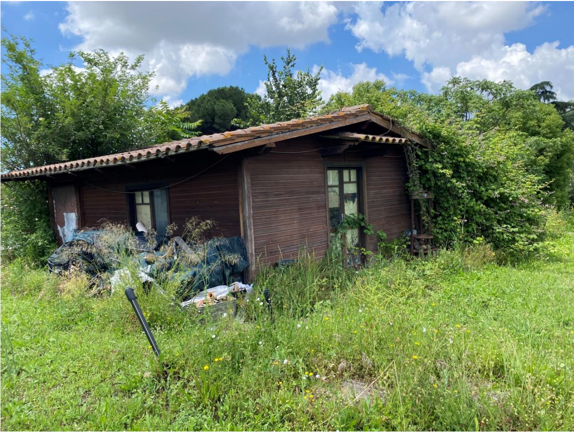
Foto n. 71 – Piano terra - Vista del prospetto principale del fabbricato a destinazione magazzino dove è ubicata la porta di accesso
