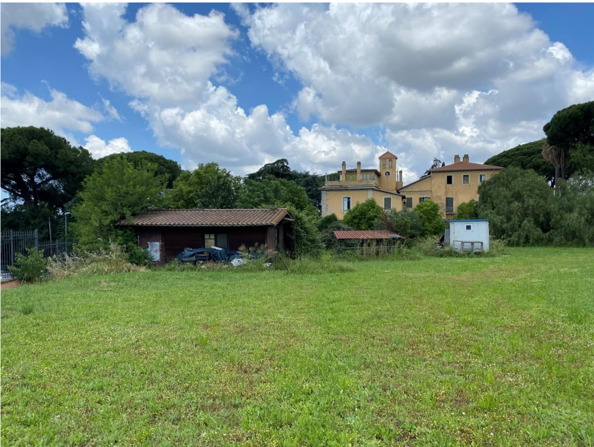
Foto n. 72 - piano terra – Vista da lontano del fabbricato a destinazione magazzino
