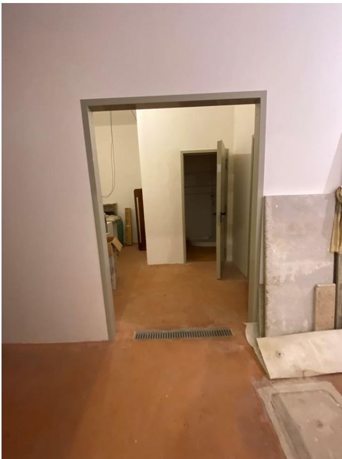
Foto n. 59 – piano interrato - Vista dei locali a destra del disimpegno nello specifico due locali e un bagno
