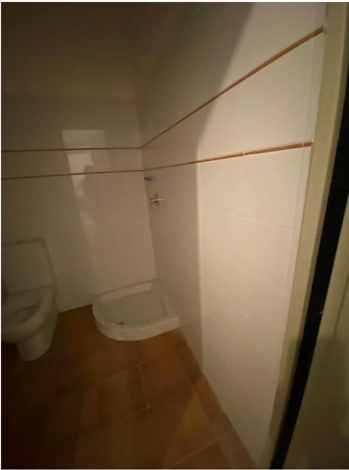
Foto n. 63 – Piano interrato - particolare del bagno
