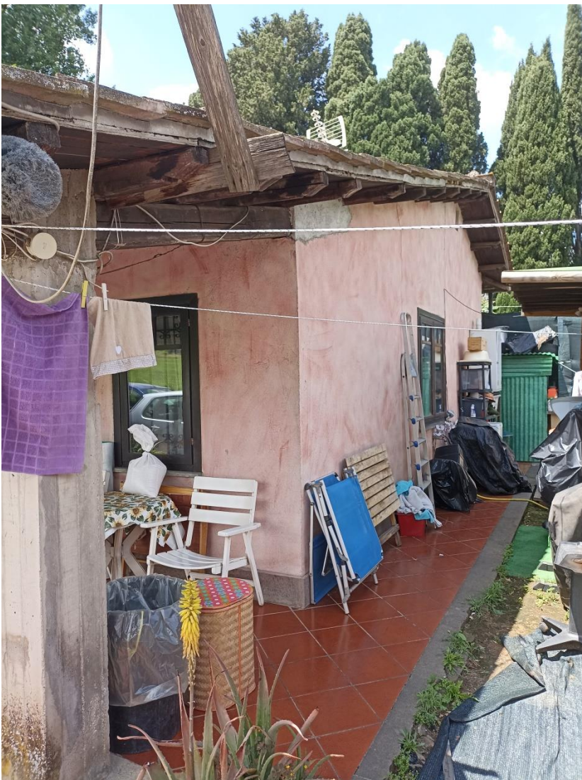
Foto n. 76 – Vista casa custode lato est.
