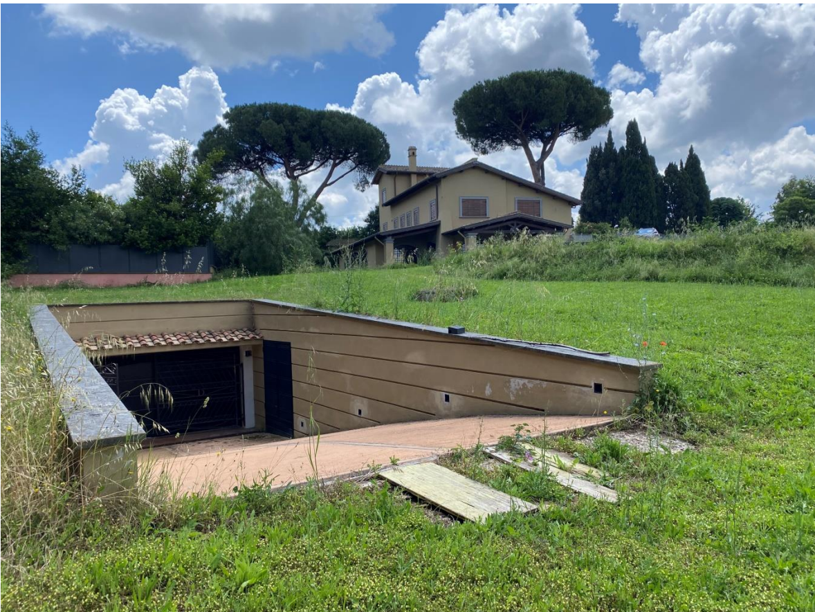
Foto n. 54 – Piano interrato - rampa di accesso al piano interrato con in fondo la Villa Principale
