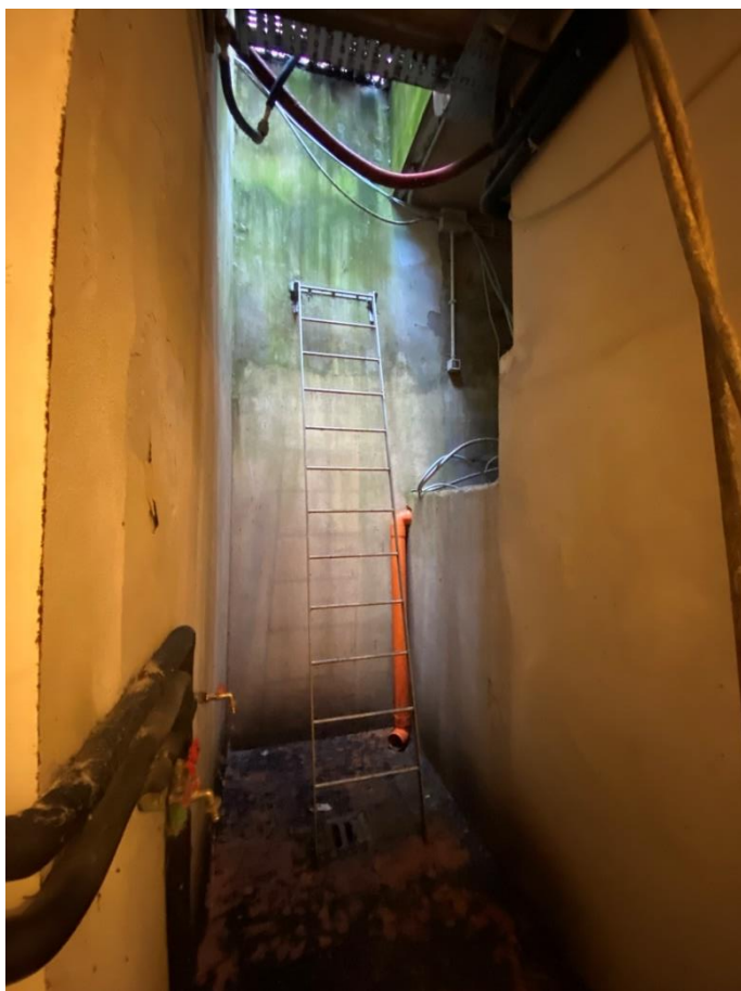
Foto n. 65 – Piano interrato – Particolare dello scoperto con a destra la galleria dove sono le tubazioni che portano alla villa principale.
