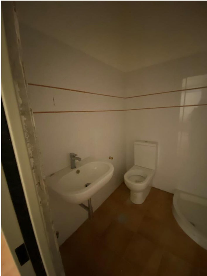
Foto n. 62 – Piano Interrato - vista del bagno interno ai due locali a destra del disimpegno
