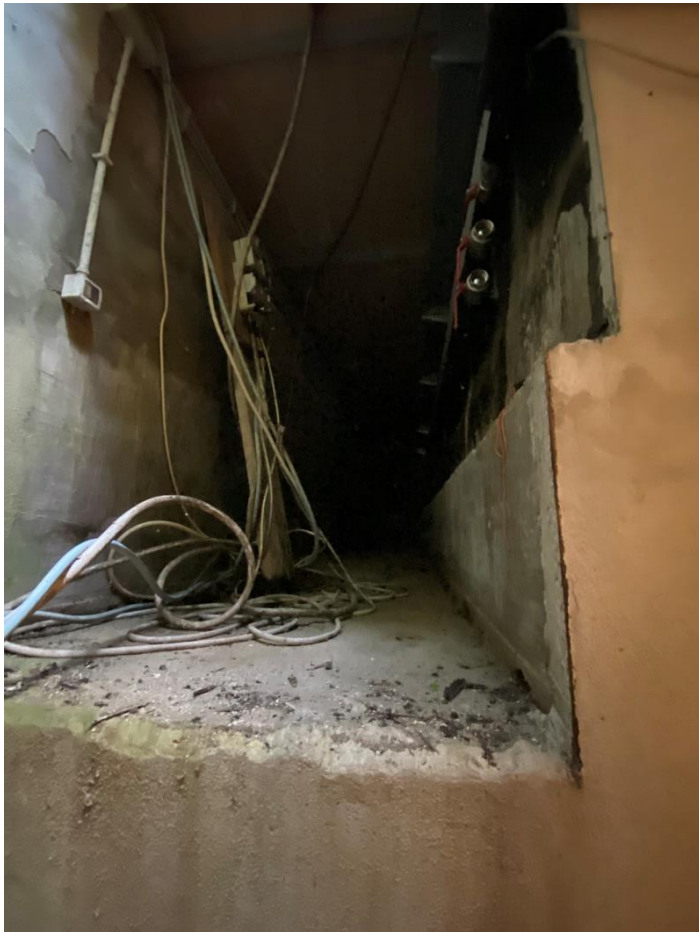
Foto n. 66 – Piano interrato – particolare della galleria
