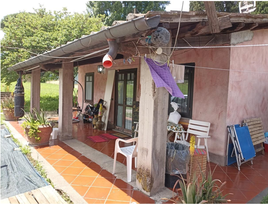
Foto n. 75- Vista casa custode lato sud
