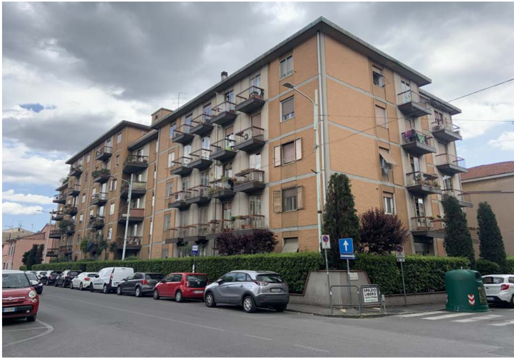
Foto 1 - Vista del complesso condominiale
