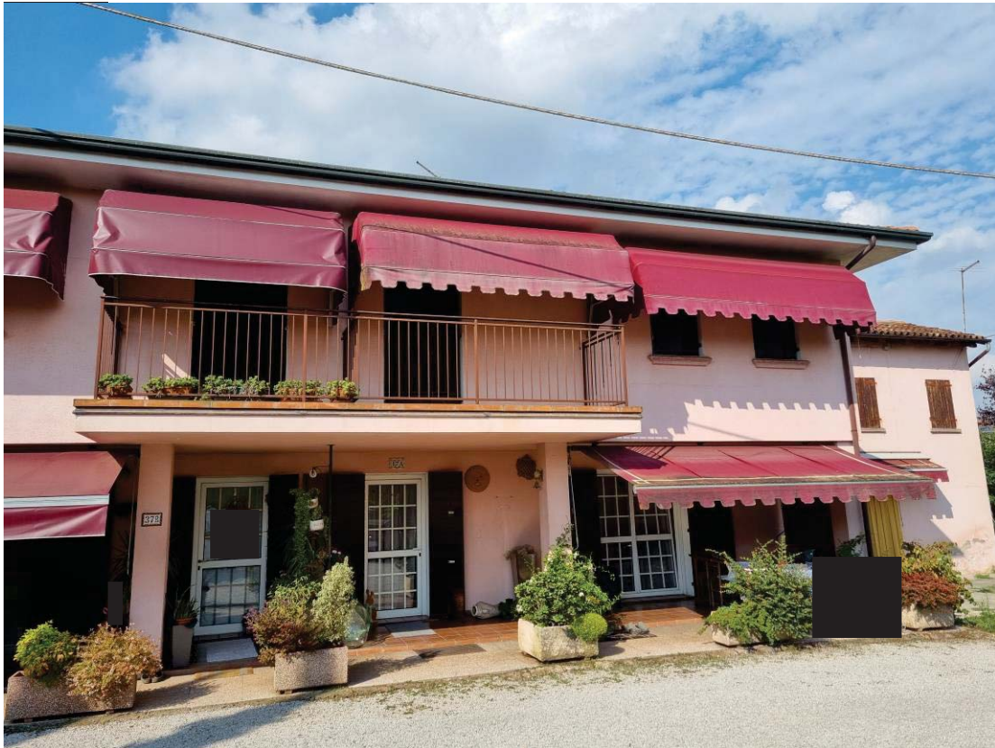
BENE 01 - VISTA ESTERNA SUD
