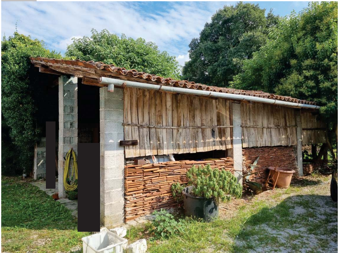
BENI 04-05 - VISTA ESTERNA OVEST
