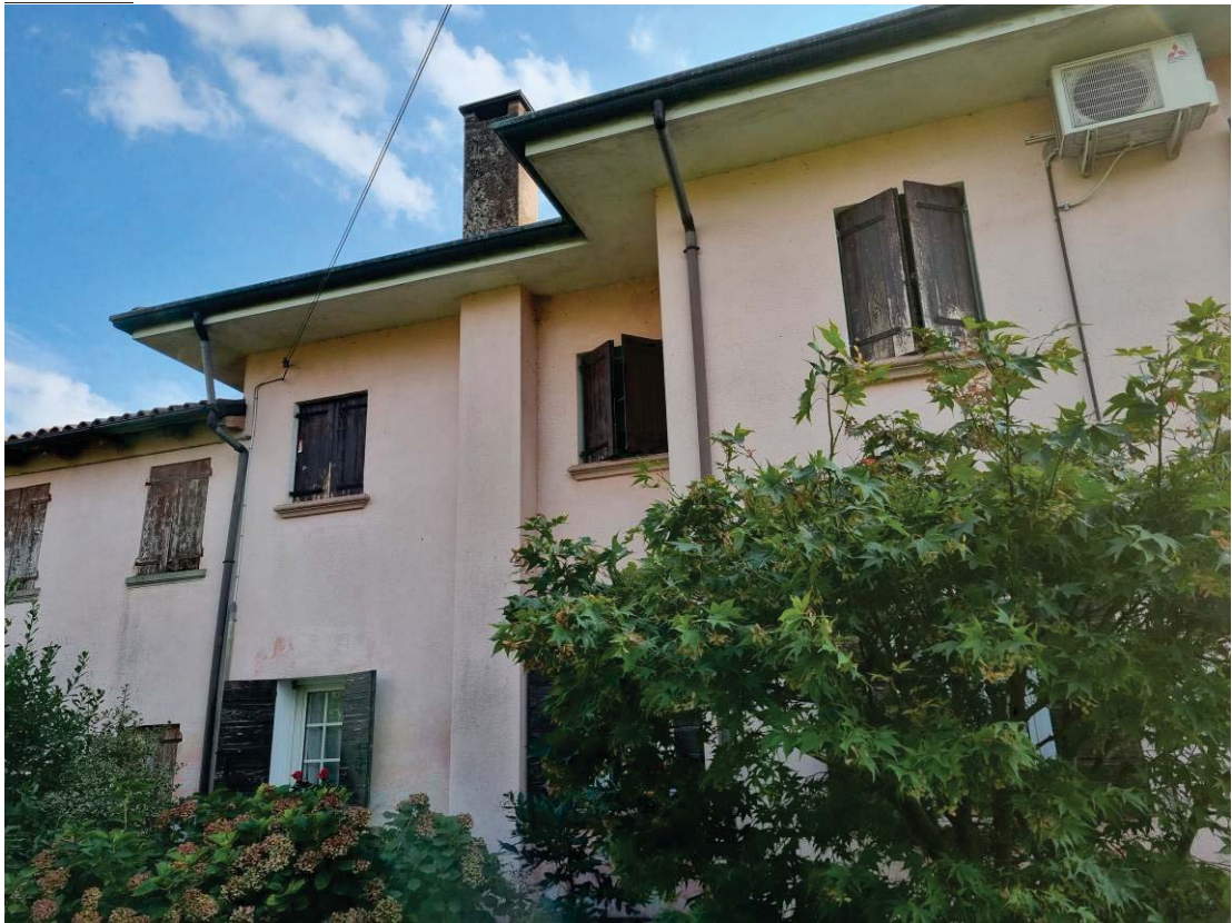
BENE 01 - VISTA ESTERNA NORD
