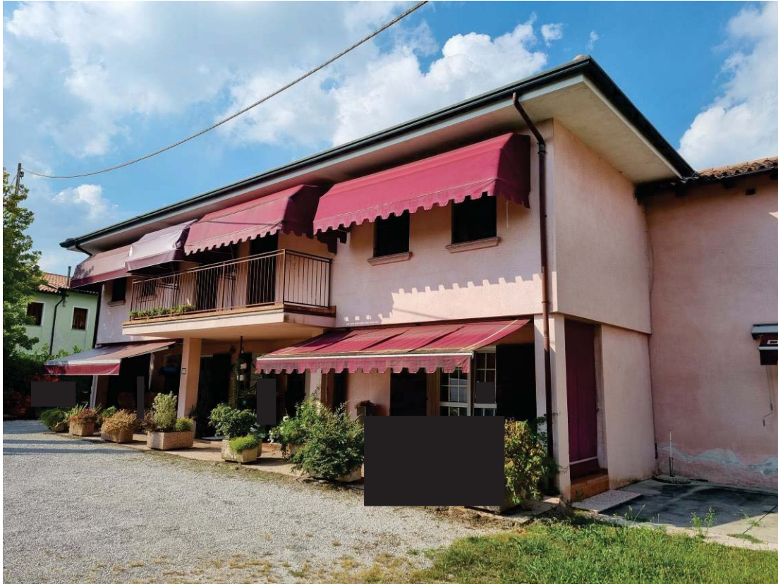
BENE 01 - VISTA ESTERNA SUD
