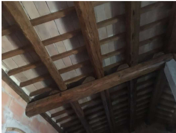
Foto 18: Fabbricato rurale lotto –D- veduta interna.
