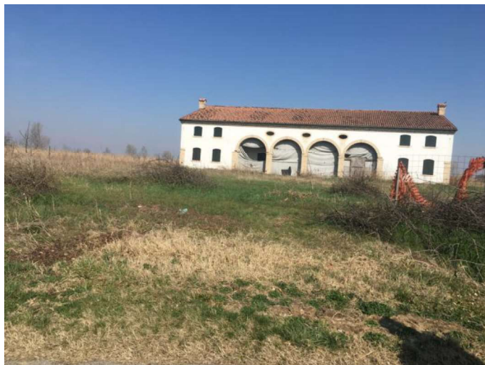
Foto 12: Vista d'insieme del fabbricato rurale lotto –D-
