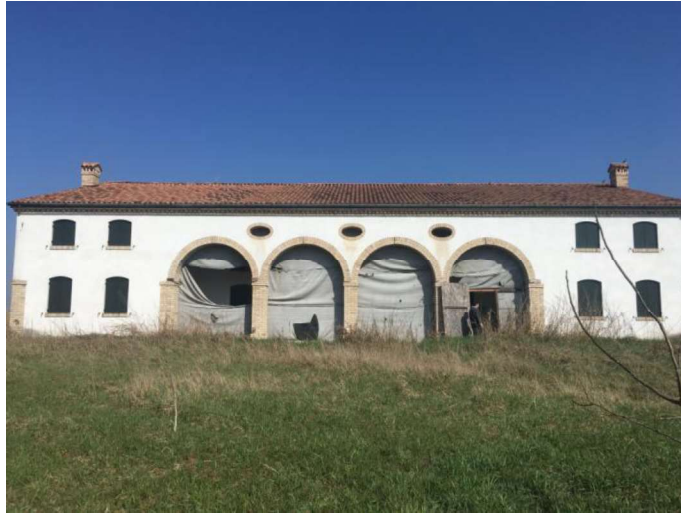
Foto 11: Vista d'insieme del fabbricato rurale lotto –D-.
