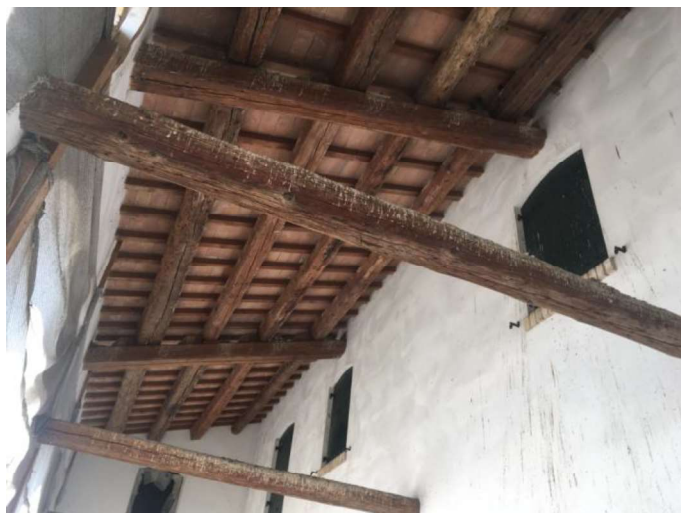
Foto 13: Fabbricato rurale lotto –D-, portico.
