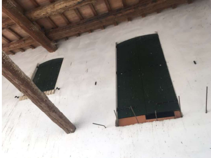
Foto 14: Fabbricato rurale. Portico.
