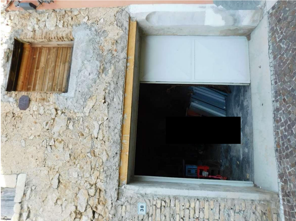
Foto 3 – Accesso carraio dalla Via Giardino
