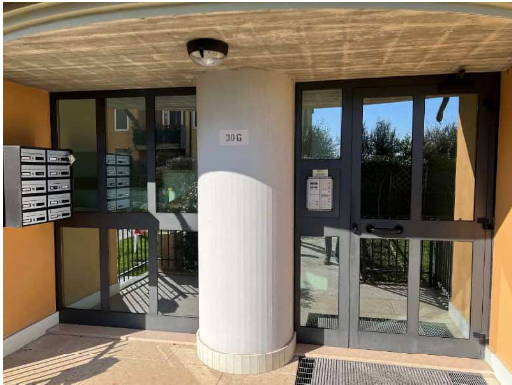
Porta ingresso al complesso
