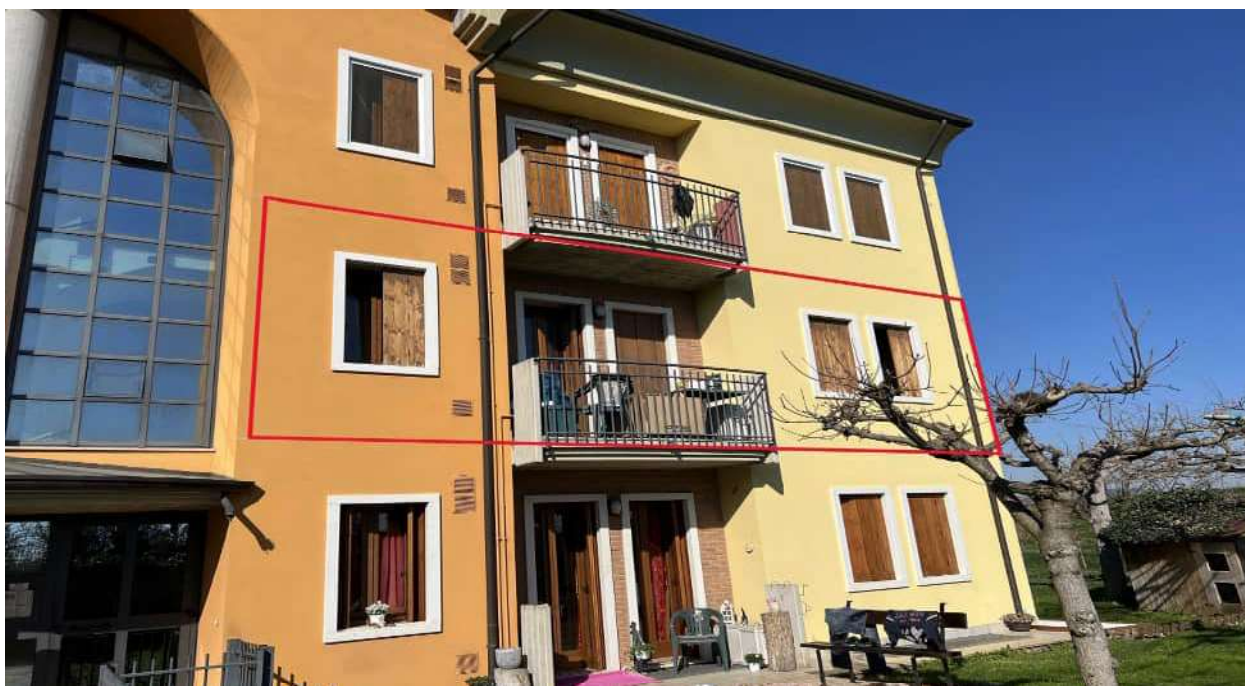
Esterno appartamento P1
