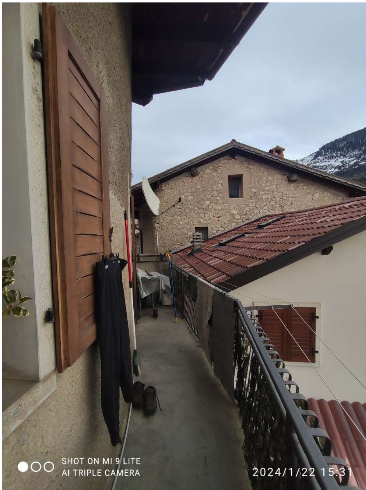
Figura 19: poggiolo - piano primo.
