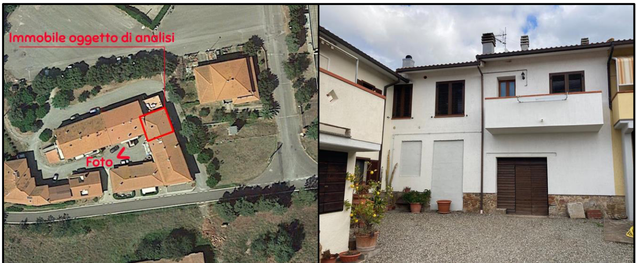
Accesso all'immobile: foto aerea e vista dell'accesso all'unità immobiliare
