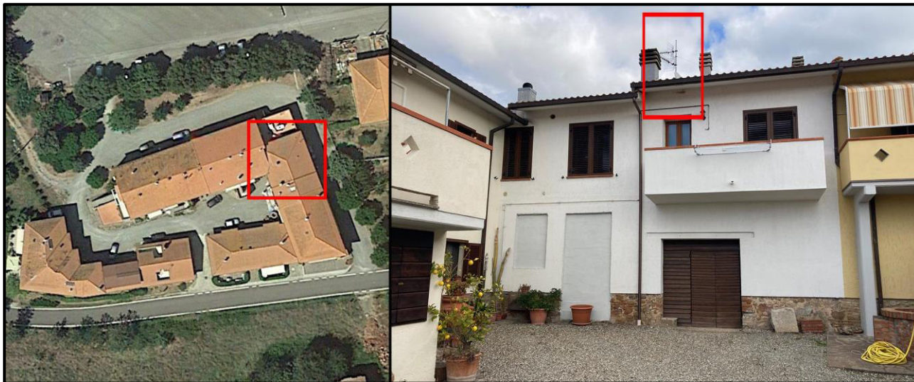
Impianto radiotelevisivo: posizione immobile con individuazione dell'antenna condominiale
