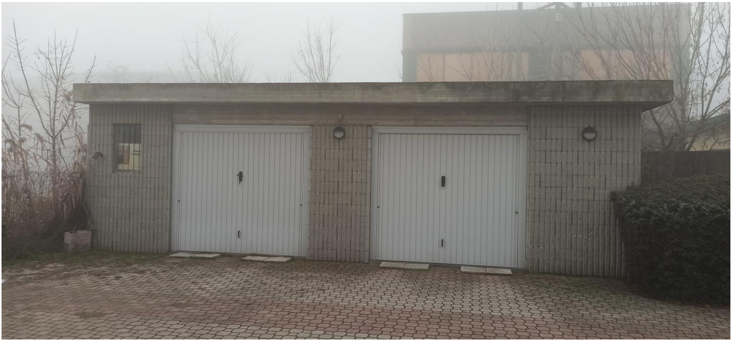
VISTA COPERTURA TETTO
