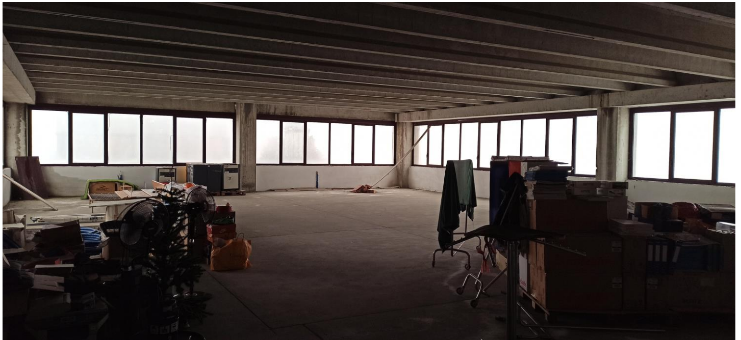
VISTA CAPANNONE P1 SUB 3
