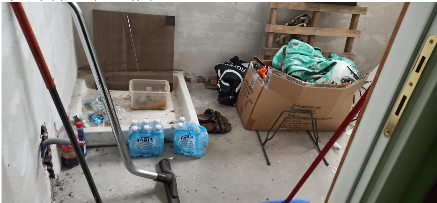
VISTA BAGNO CAPANNONE P.1° SUB 3
