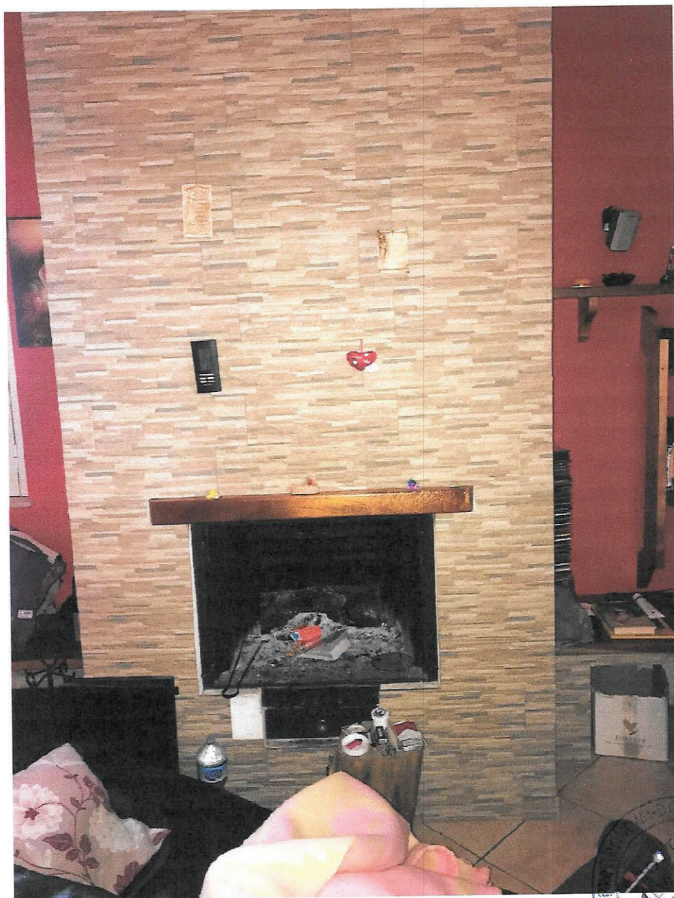
Foto 7 termocamino piano T
