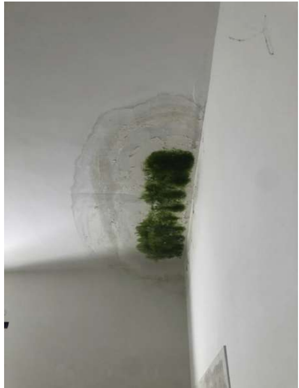
Particolare interno foto n° 10
