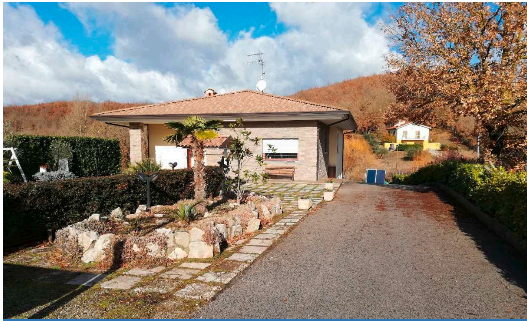
4. Veduta del prospetto anteriore dell'immobile dalla strada privata di accesso al lotto
