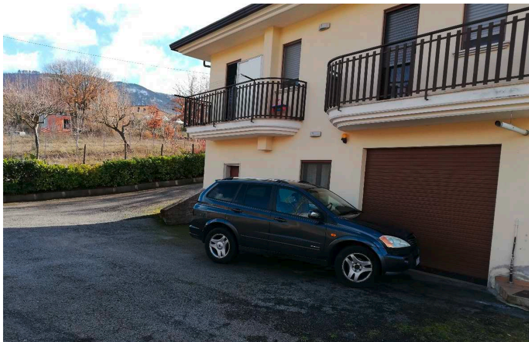
5. Veduta del prospetto posteriore dell'immobile
