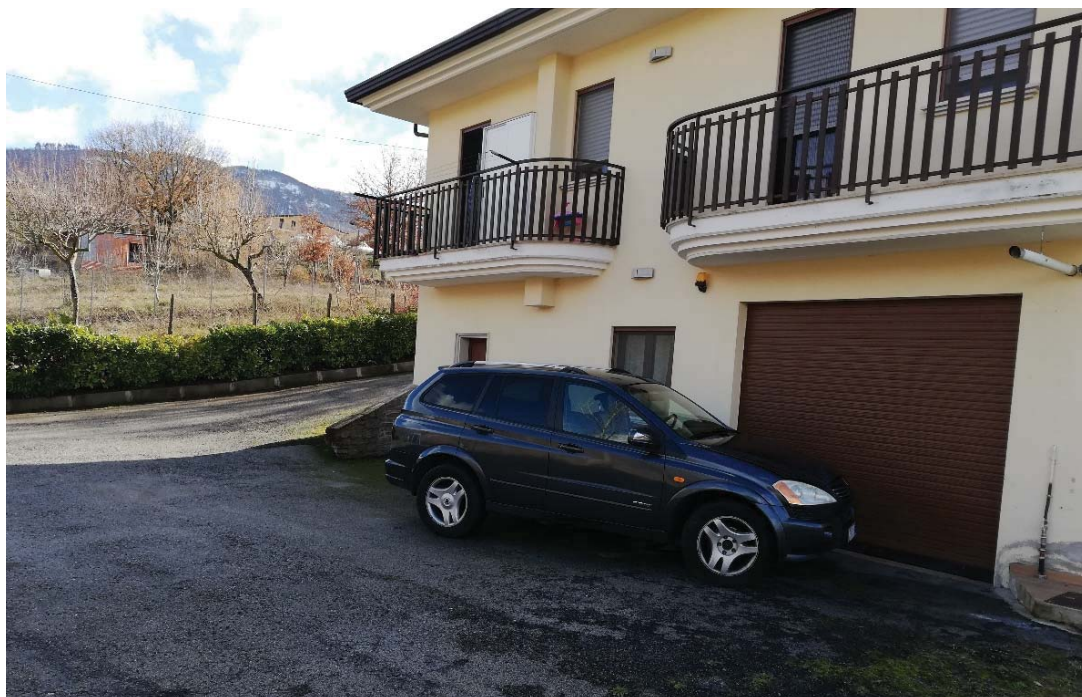
2. Veduta del prospetto posteriore dell'immobile
