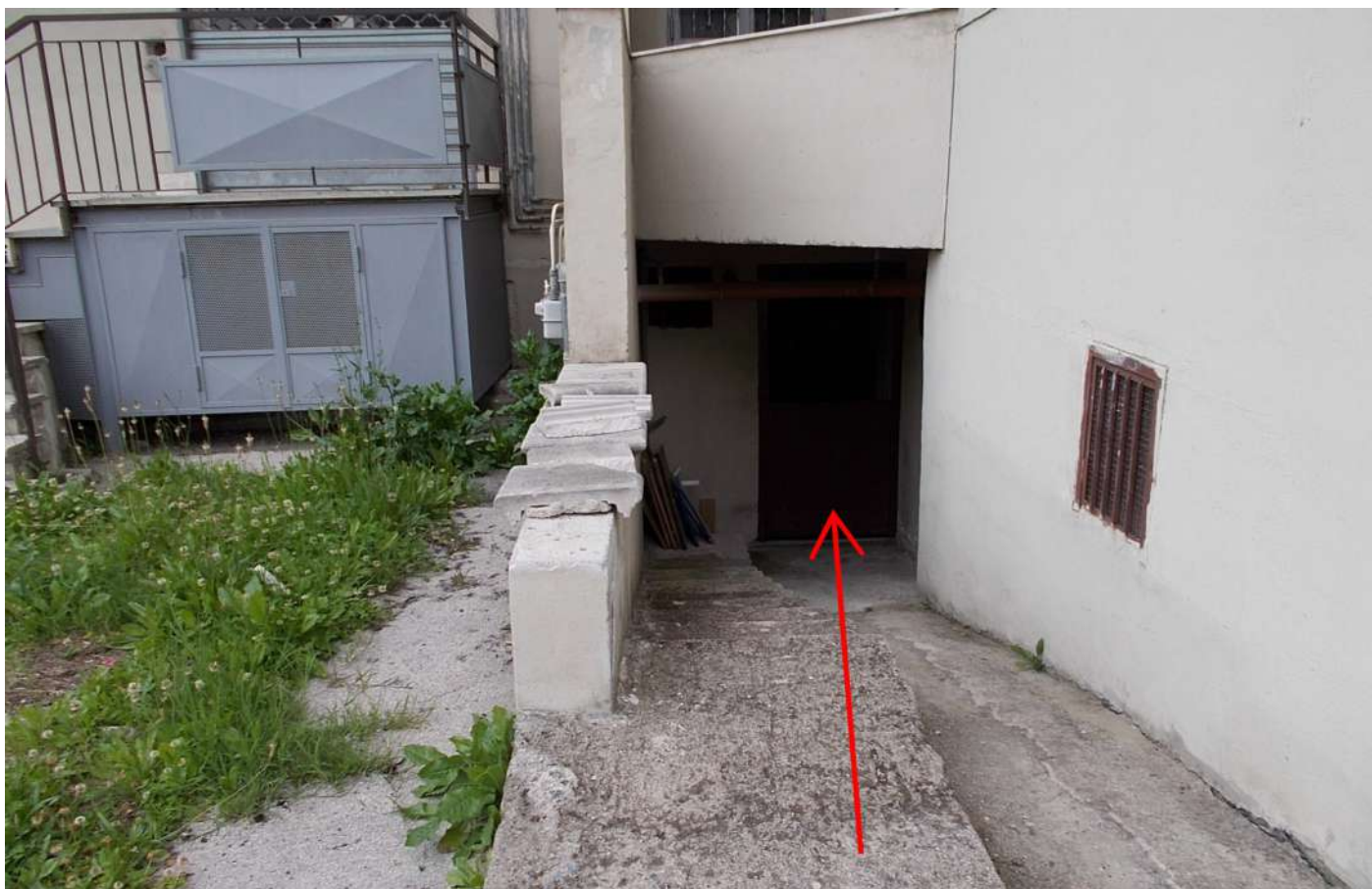
Rampa di accesso al piano primo sottostrada
