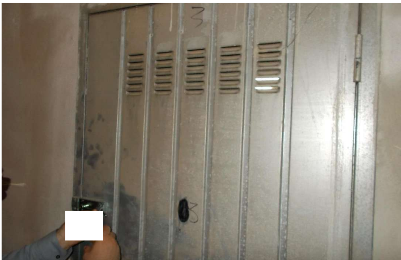
Porta di ingresso della cantinola al PS1
