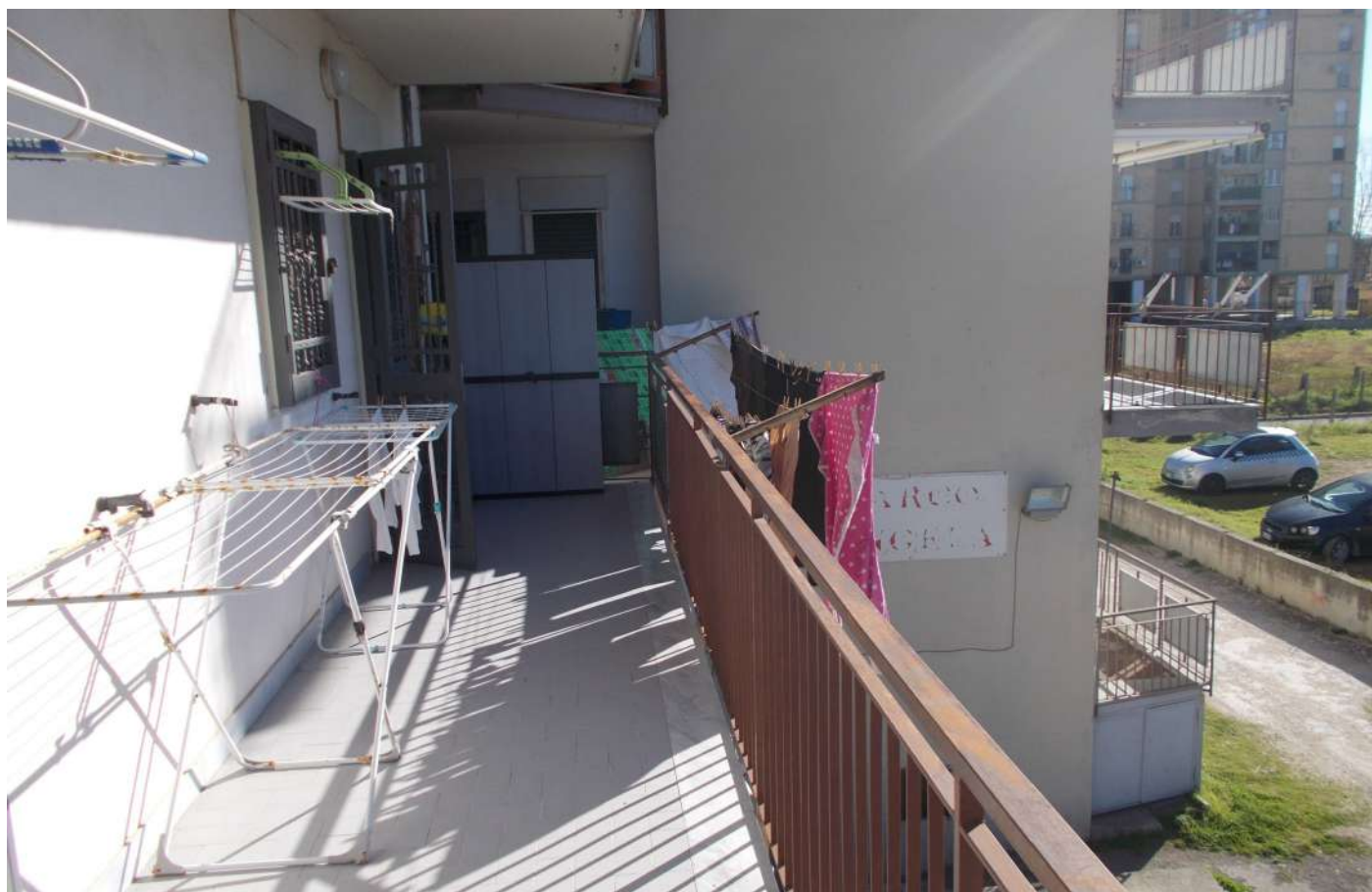
Vista del balcone lato sud dell'immobile
