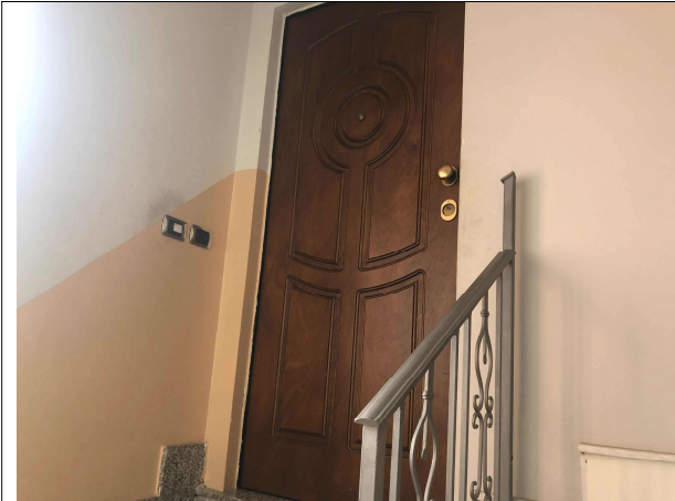
Portoncino di ingresso realizzato sulla scala comune (vista esterna all'appartamento)
