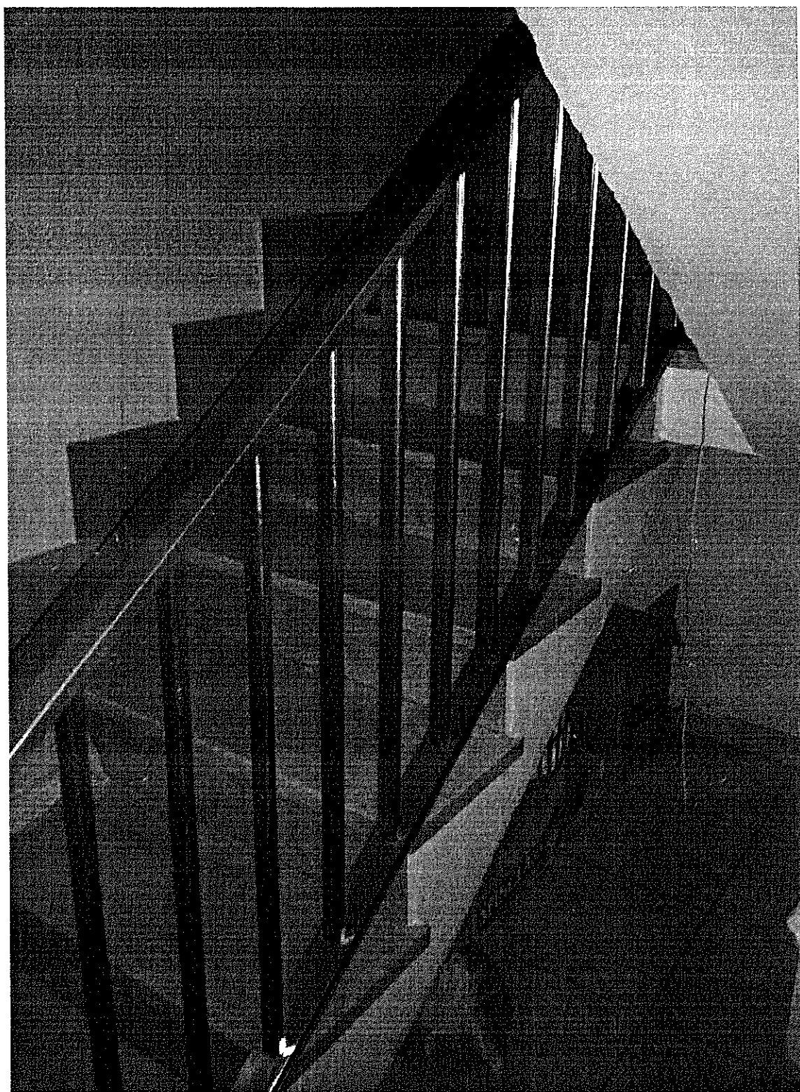
Foto n.7 Vano scala visto dal piano terra
