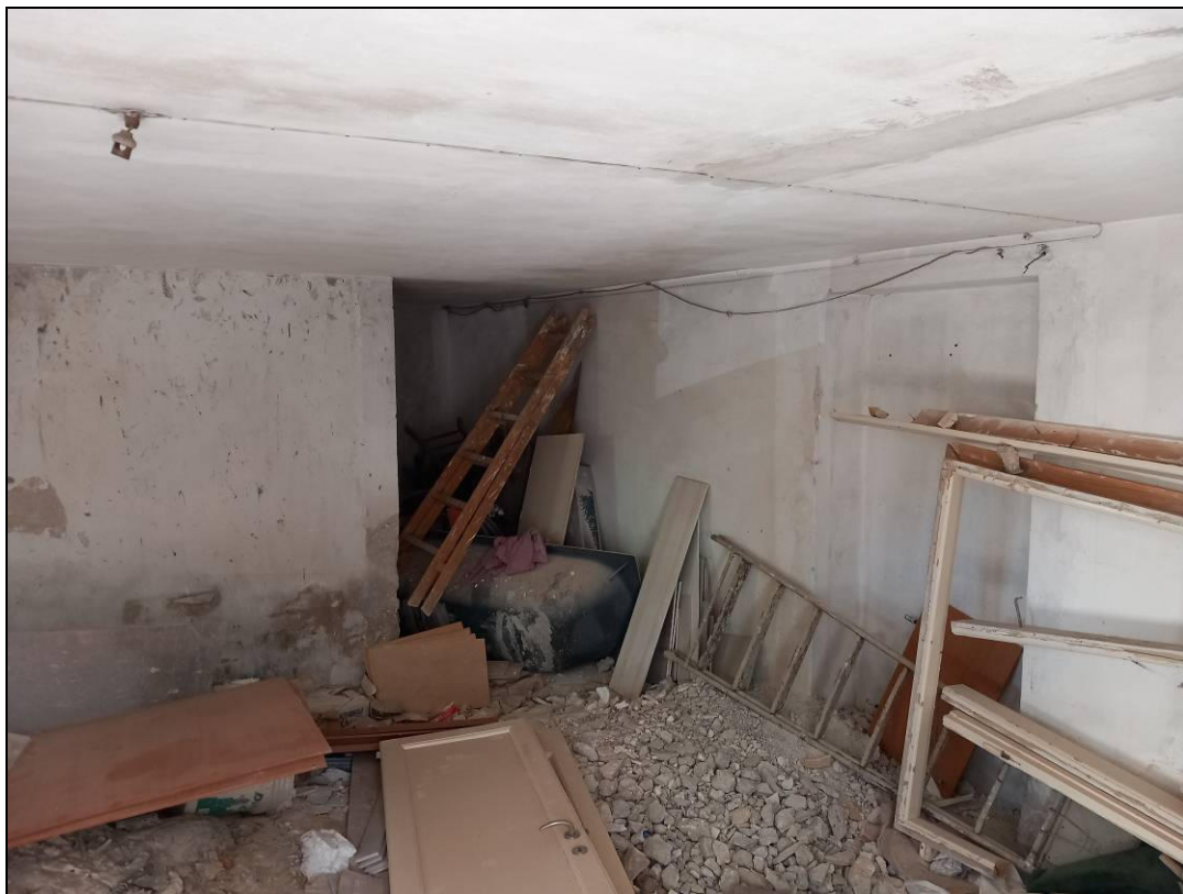
Foto 6: Vista dell'interno del locale
