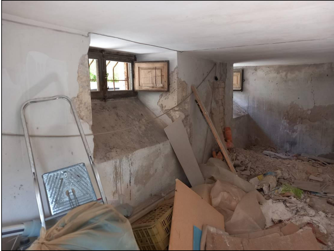
Foto 5: Vista dell'interno del locale
