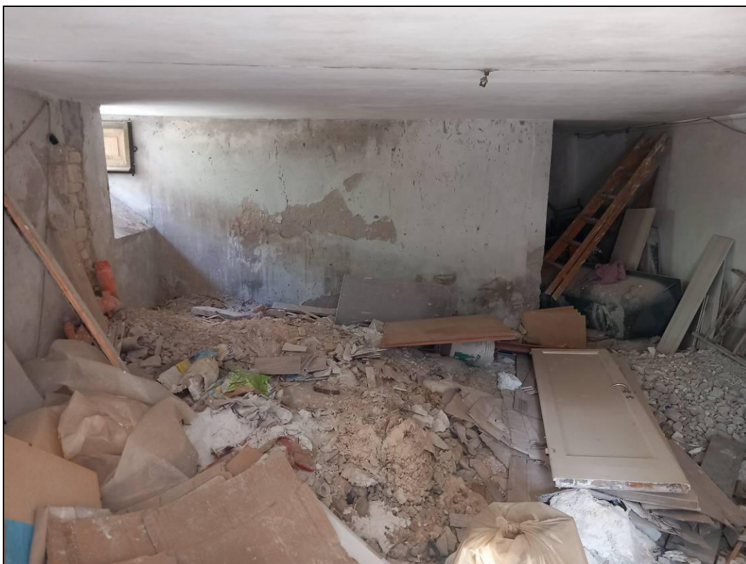
Foto 4: Vista dell'interno del locale
