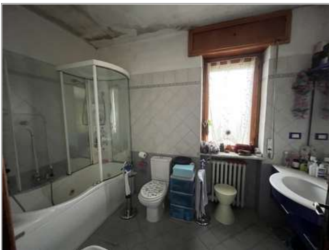
FOTO 6: vista del bagno verso la parete Nord
