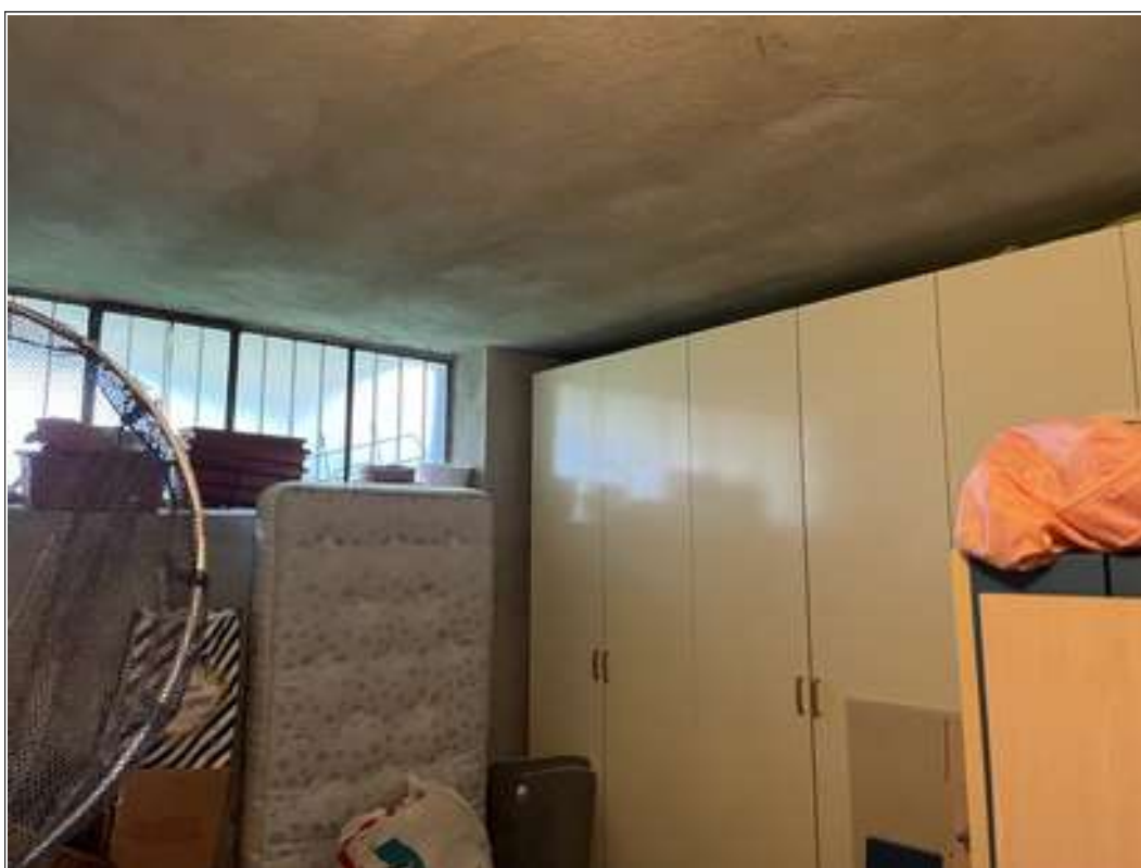
FOTO 12: vista dell'interno della cantina al piano seminterrato
