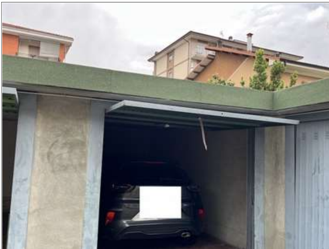
FOTO 13: vista del box-auto nel cortile interno
