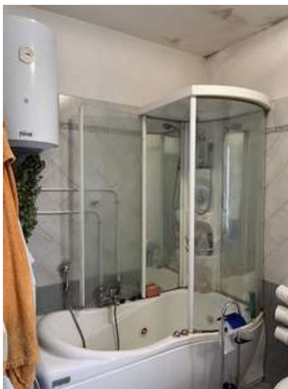
FOTO 8: CONFRONTO: SOPRALLUOGO 2021 stato del soffitto
