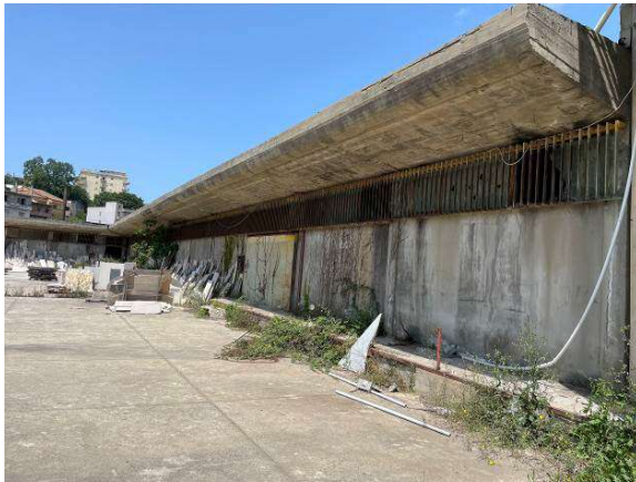
FOTO 1 – prospetto del piano terra
