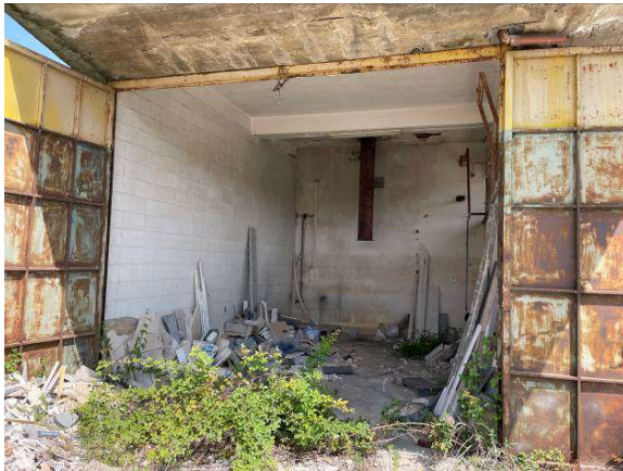
FOTO 3 – locale ex centrale termica
