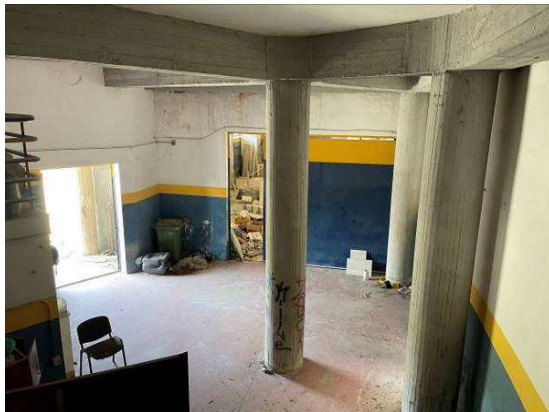
FOTO 21 – androne di accesso
