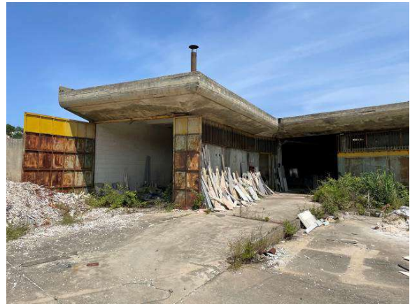
FOTO 2 – prospetto del piano terra
