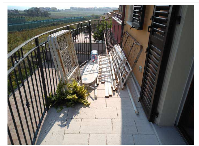
Foto n. 12 – Vista balcone lato est (lato mare)
