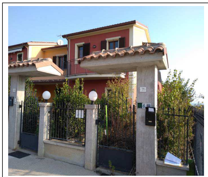
Foto n. 3 – Vista ingresso abitazione lotto 3
