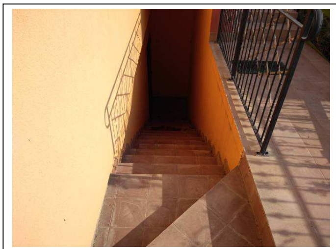
Foto n. 15 – Vista scala per PS1 (al garage)
