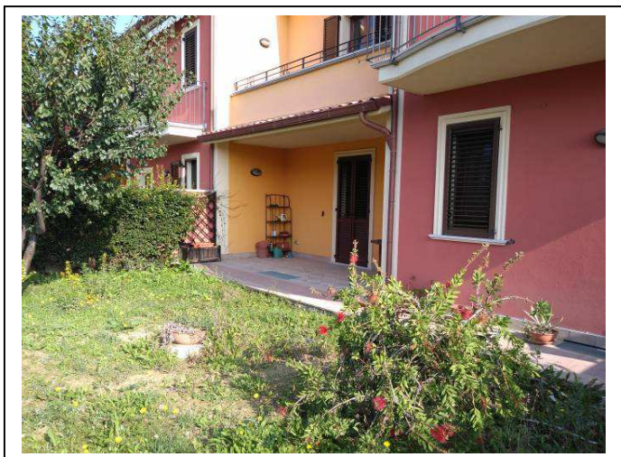
Foto n. 12 – Vista corte lato ovest
