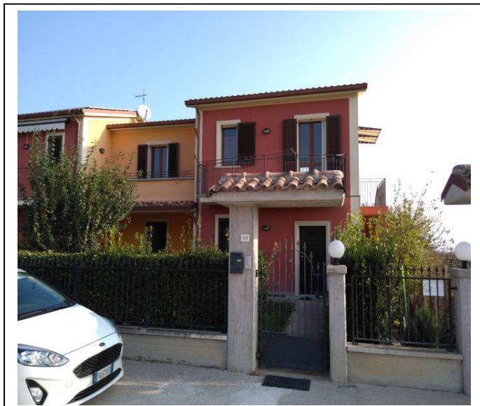
Foto n. 3 – Vista ingresso abitazione lotto 2
