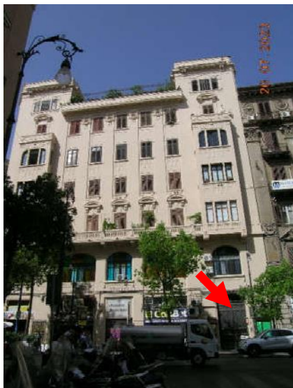
Foto 1 – Edificio via Roma 188 (p.la 122)
