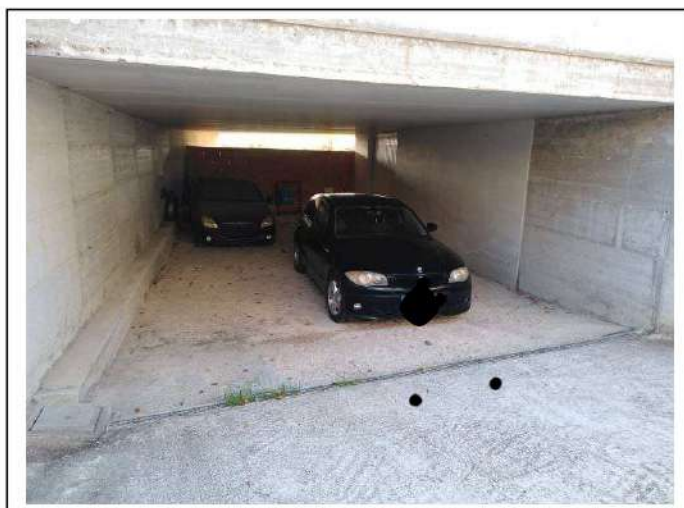
Foto n. 19 – Vista area passaggio ex garage al PS1
