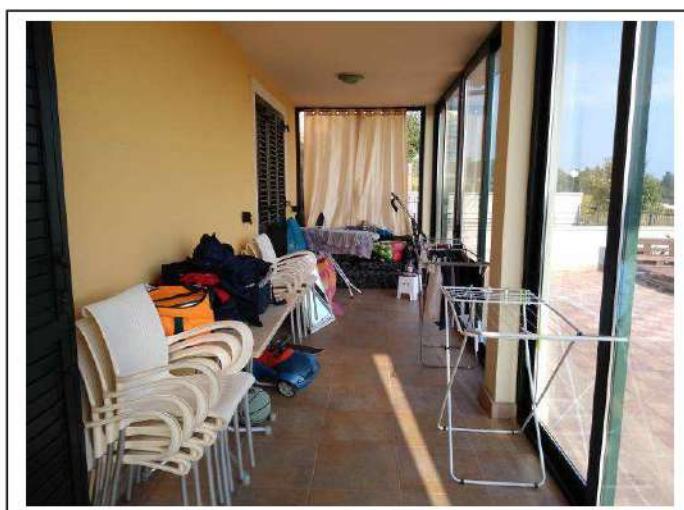
Foto n. 9 – Vista del porticato chiuso lato est
