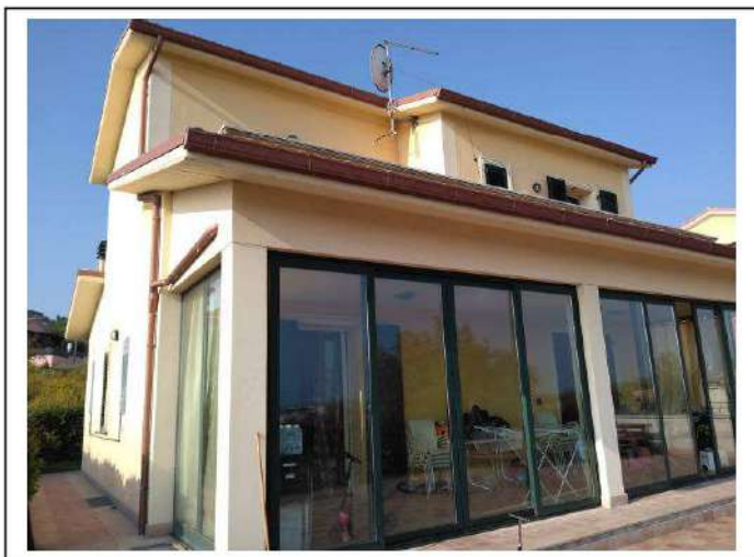
Foto n. 6 – Vista esterna lato sud-est con porticato chiuso
