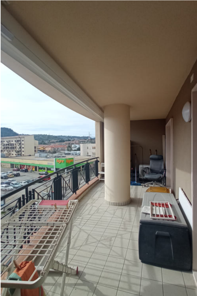
VISTA ESTERNA - BALCONE S/E
