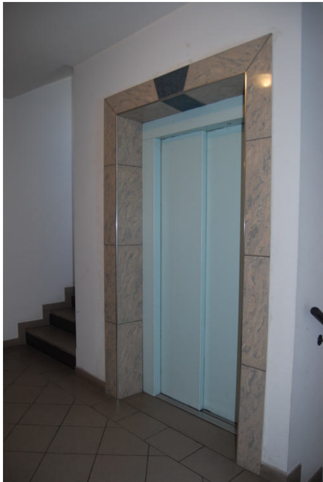
VISTA ASCENSORE SCALA B FOTO N.7
