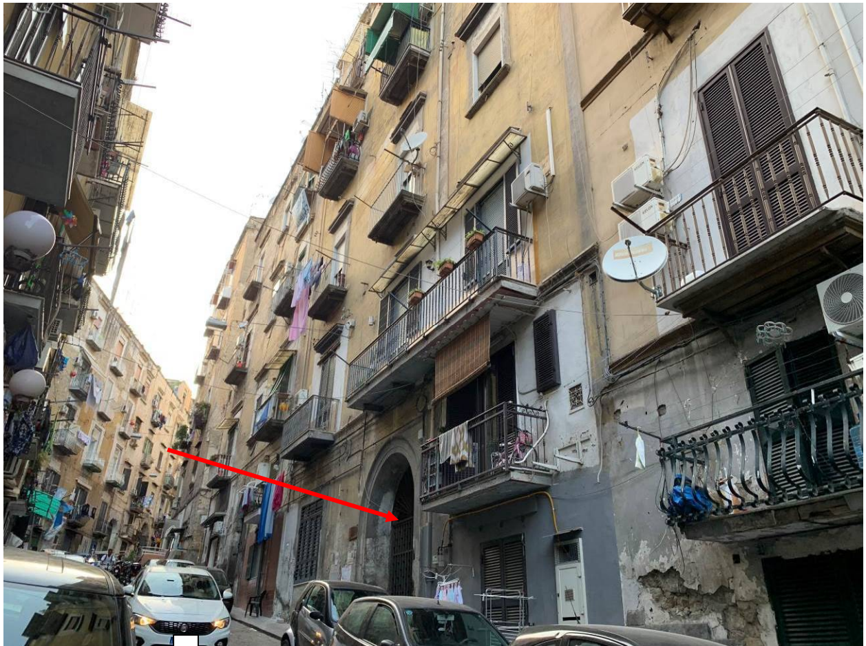
Foto 01 – Il fabbricato di via Francesco Saverio Correrà 177
