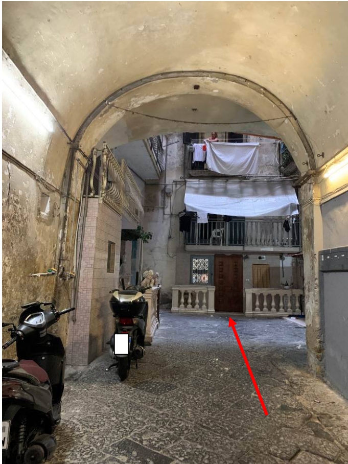
Foto 03 – Corte interna al fabbricato di via Francesco Saverio Correrà 177
