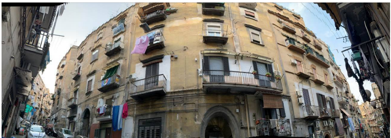
Foto 02 – Il fabbricato di via Francesco Saverio Correrà 177
