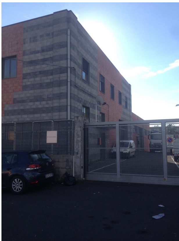
Foto 5 – Secondo ingresso carrabile Via Ludovico Ariosto Aci Sant'Antonio (CT)
