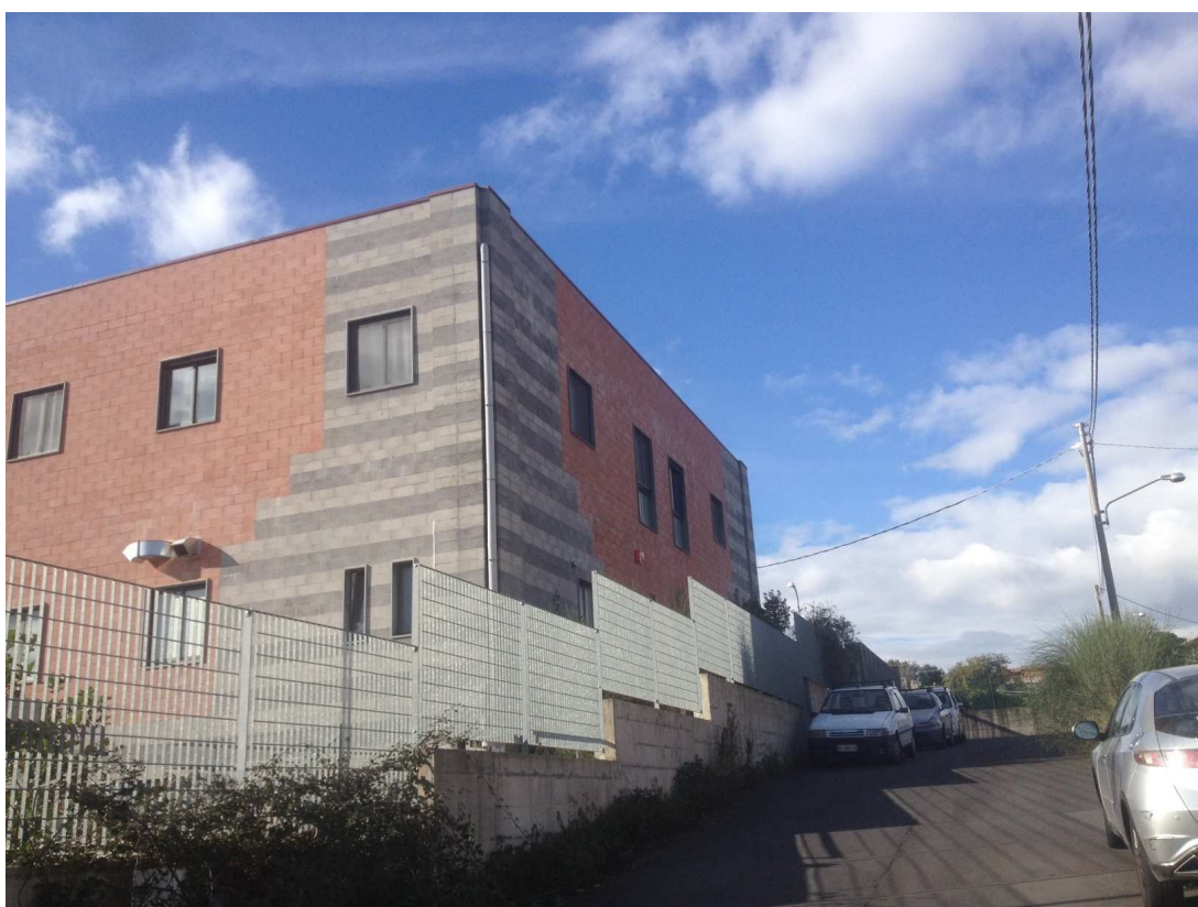
Foto 2 – Angolo nord est immobile Via Ludovico Ariosto Aci Sant’Antonio (CT)
