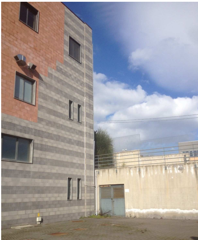
Foto 4 – Angolo nord est immobile Via Ludovico Ariosto Aci Sant'Antonio (CT)
