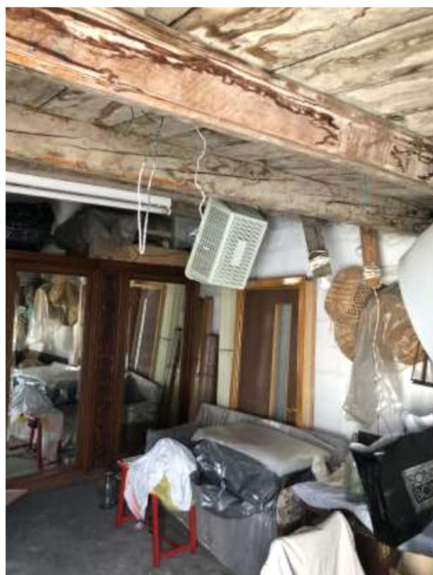
Foto 17: interno del locale di sgombero in 3° P.
