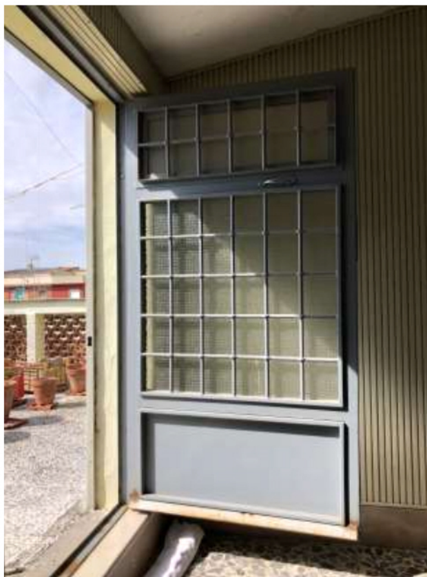
Foto 15: porta di accesso al terrazo di copertura in Piano 3°
