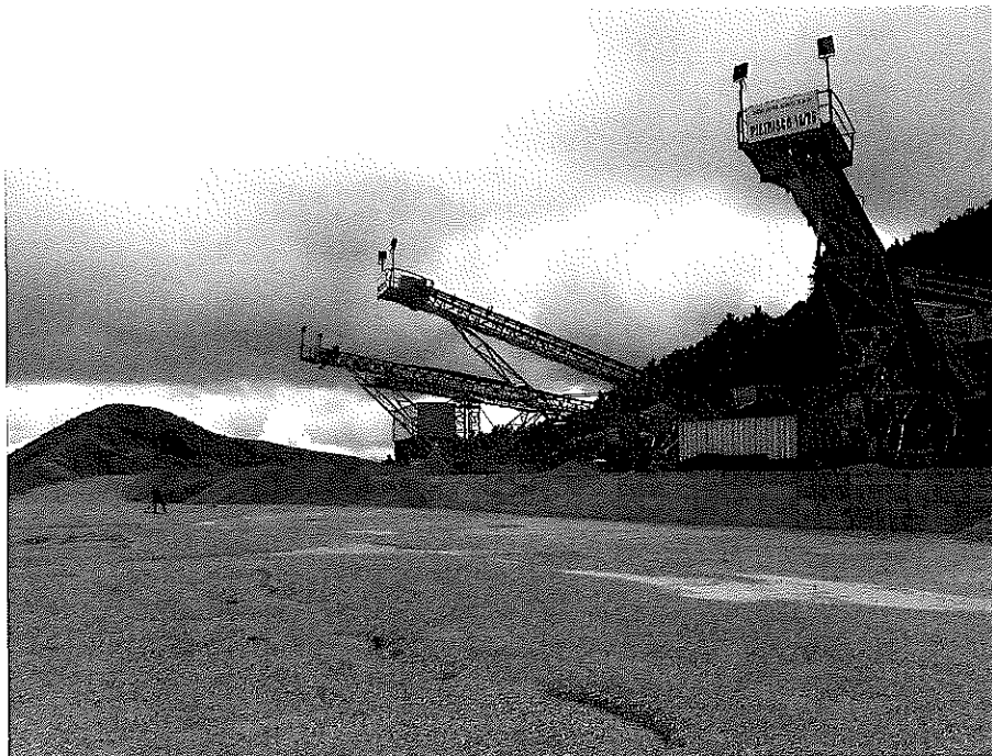
Foto 4 – piazzale di lavorazione (particolare impianto di frantumazione)
