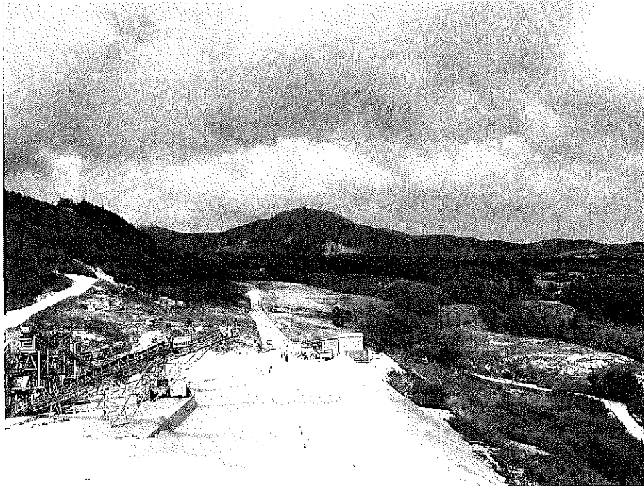
Foto 3 – piazzale di lavorazione (vista verso nord)
