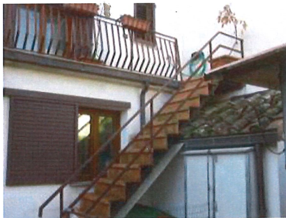
SCALA ESTERNA IN ACCIAIO DI COLLEGAMENTO PIANO TERRA-PIANO PRIMO
