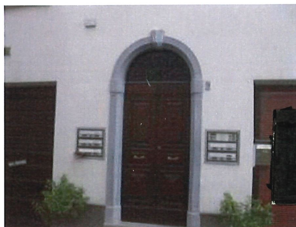
PORTONE DI INGRESSO (VIA DELLA CROCE N. 9)
