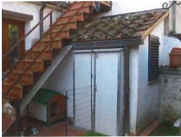
BAGNO (non autorizzato) POSTO NEL SOTTOSCALA
