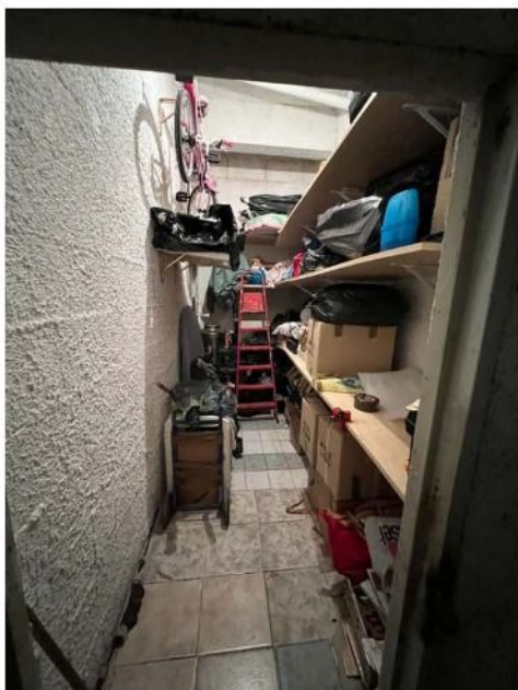
Foto 15. Vista seminterrato (cantina)
