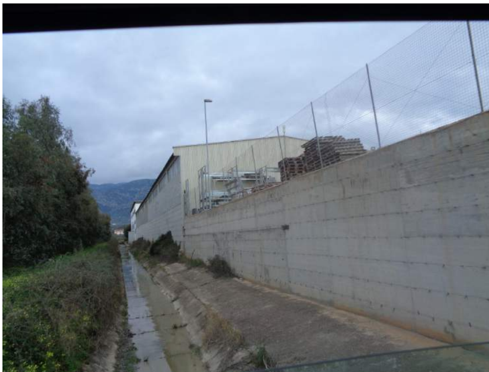
Prospetto del corpo 3 verso il canale scolmatore
