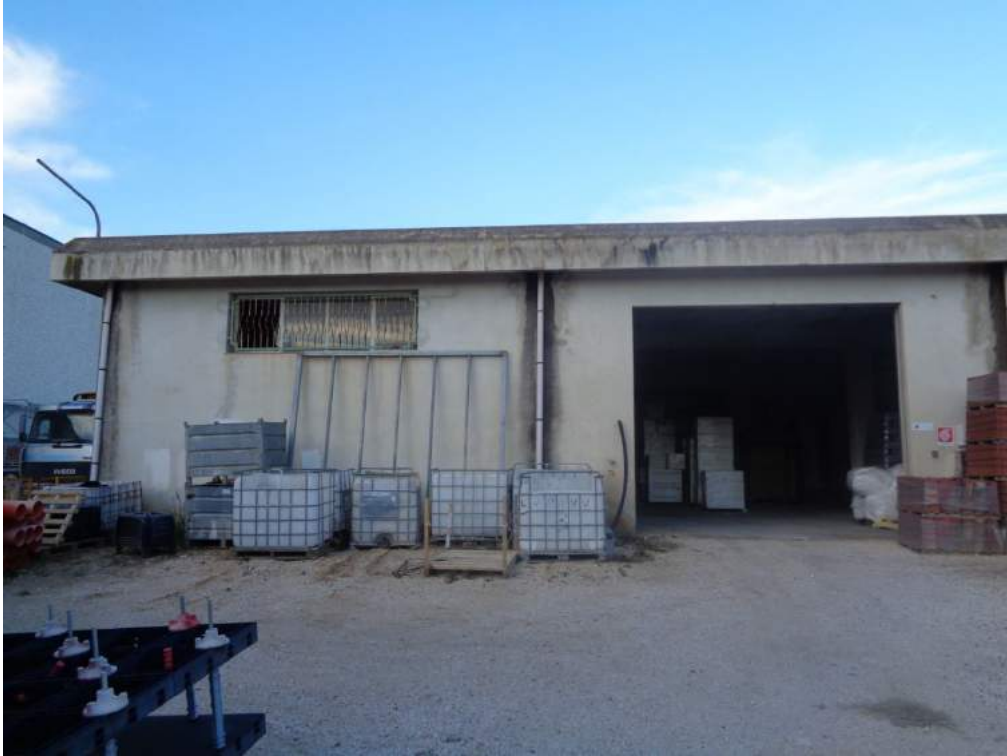
Prospetto parziale sul piazzale interno corpo 5
