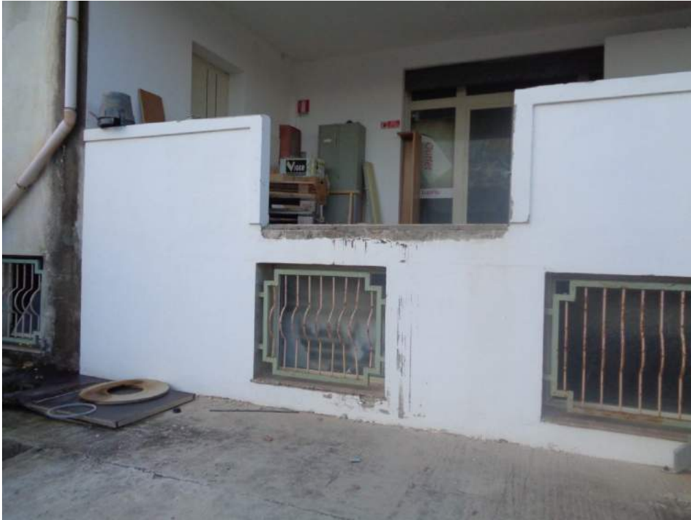
Particolare della veranda sul piazzale interno corpo 6
