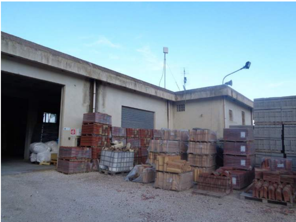
Prospetto parziale sul piazzale interno corpo 5
