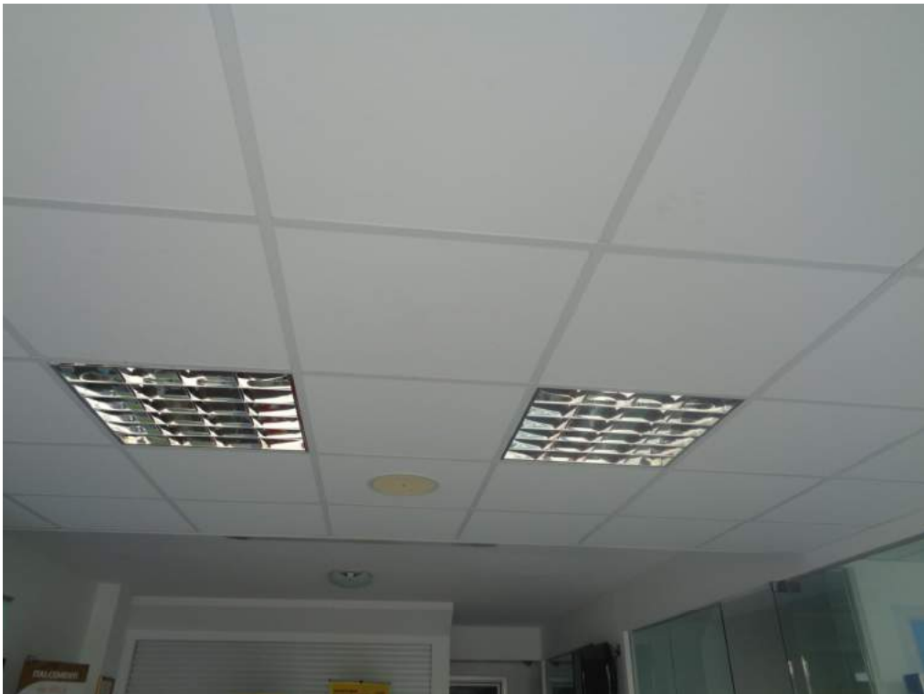
Particolare Soffitto corpo 2
