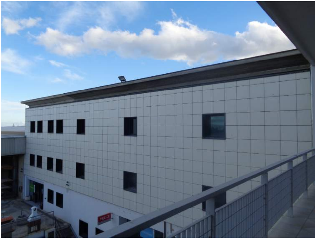
Prospetto verso piazzale interno
