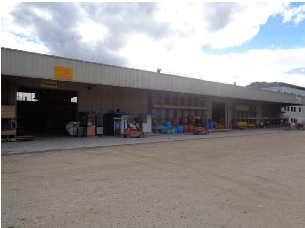
Prospetto su piazzale interno corpo 3
