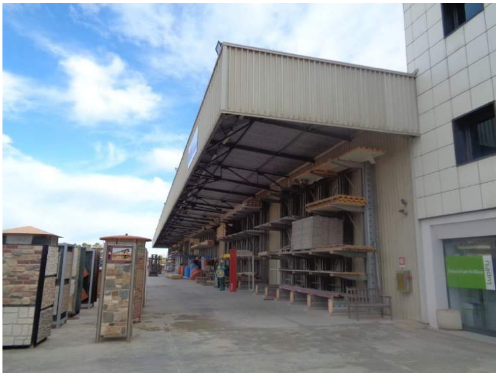
Prospetto su piazzale interno corpo 3
