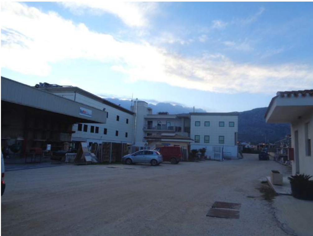
F. 41 mapp. 1 sub. 4 (fronte ingresso)
