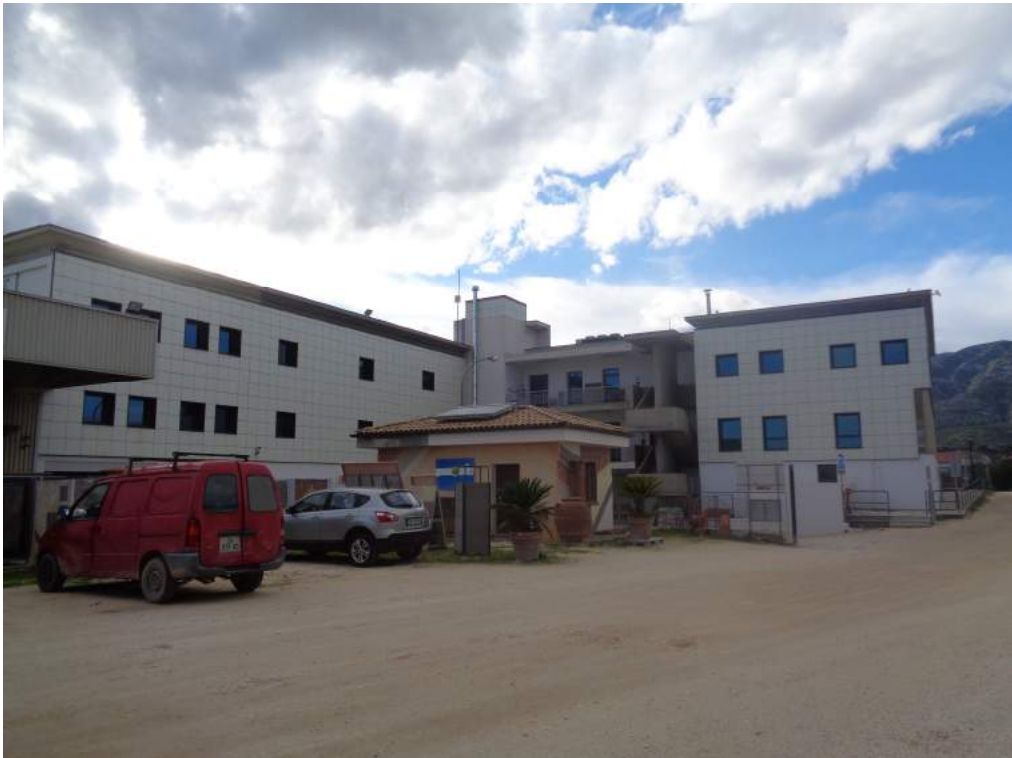
Prospetto verso piazzale interno
