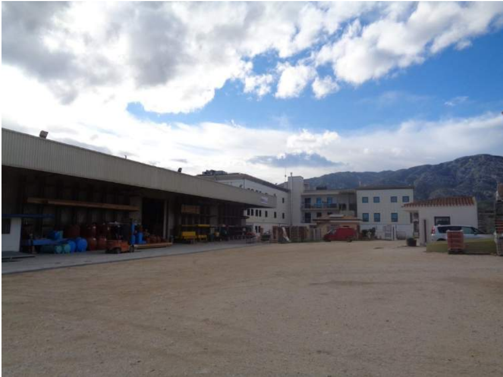
Prospetto su piazzale interno corpo 3
