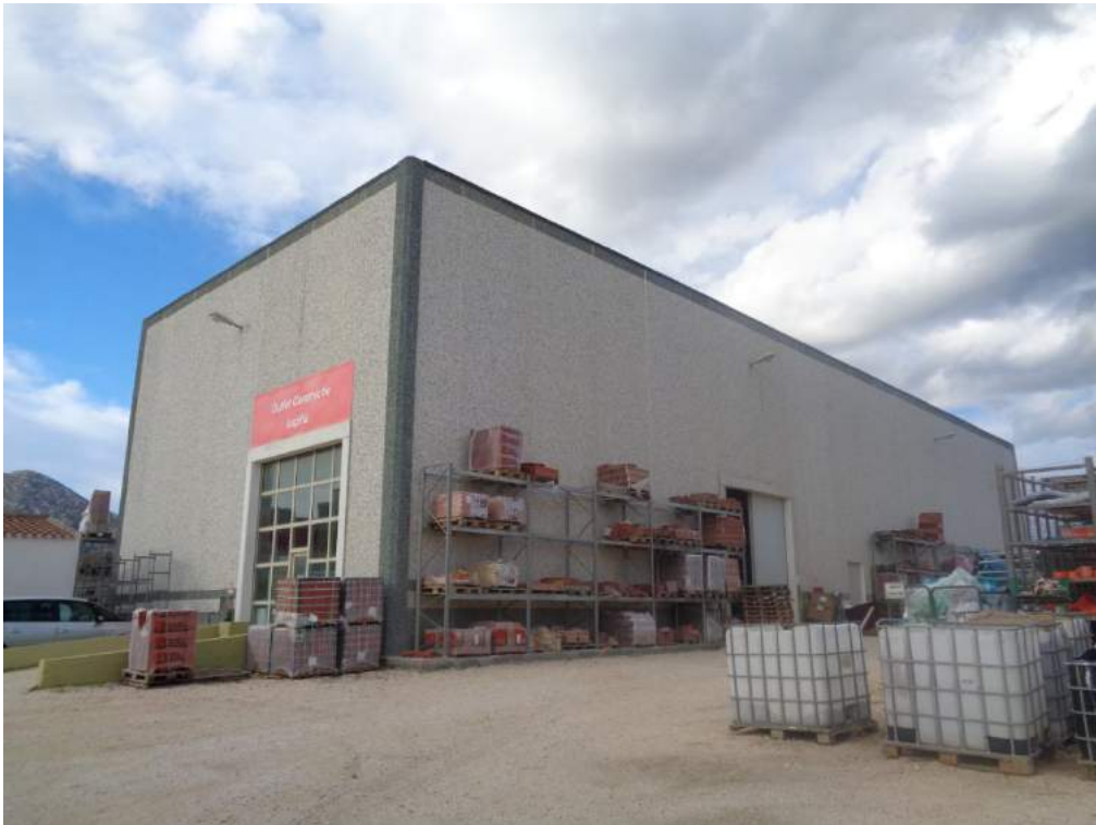
Prospetto su piazzale interno corpo 8
