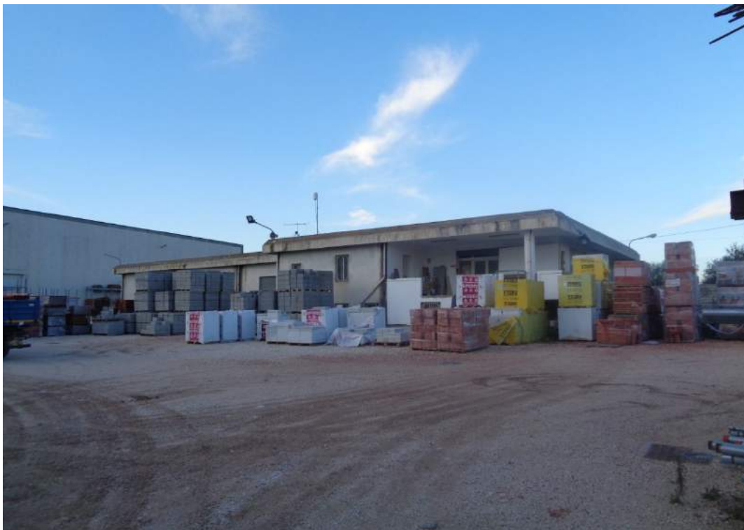
Prospetto sul piazzale interno corpo 6
