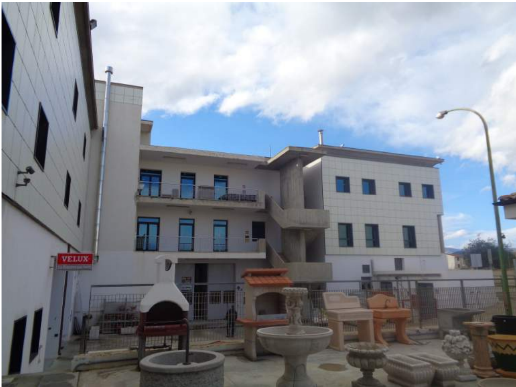
Prospetto verso piazzale interno
