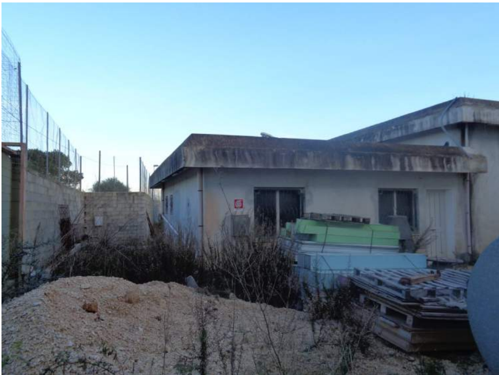
Prospetto laterale e posteriore corpo 5
