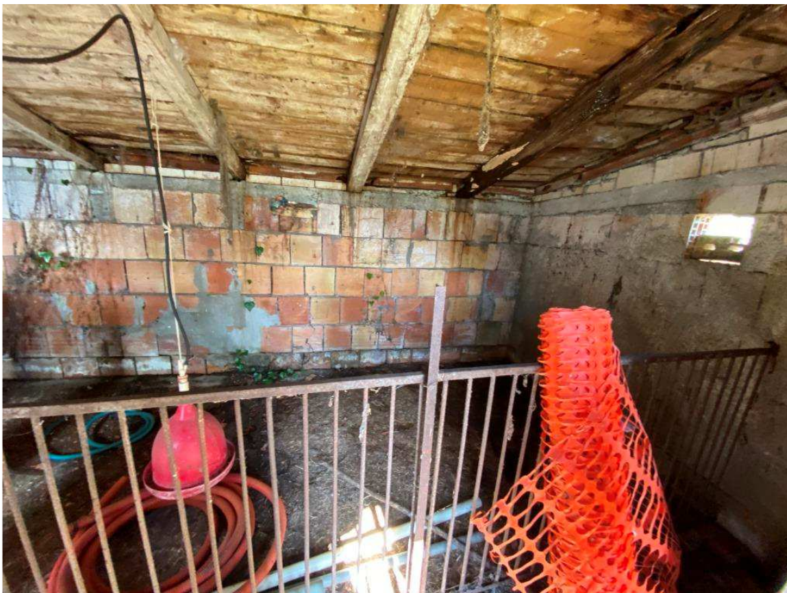
Foto 6 – Interno del manufatto
