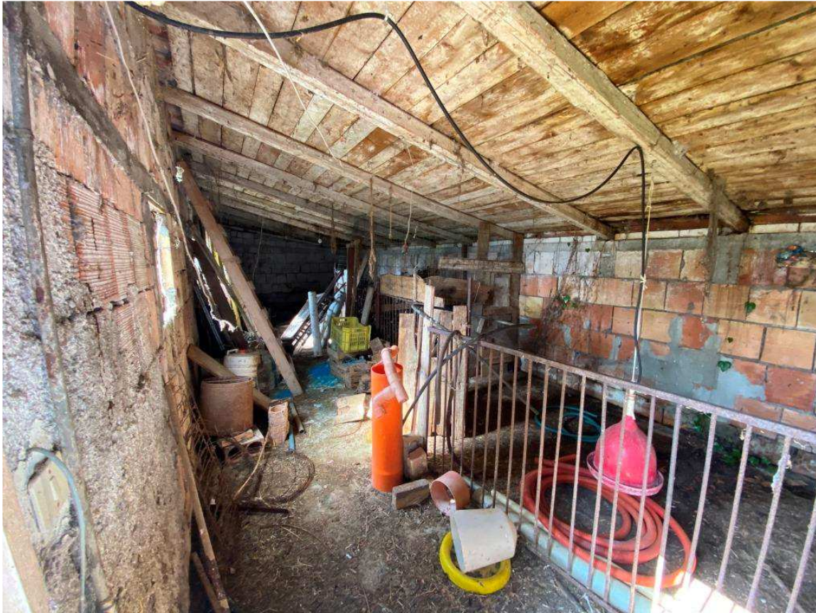
Foto 5 – Interno del manufatto
