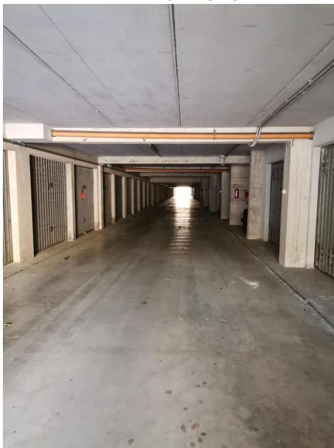
Foto n. 32: Spazio di manovra condominiale Garage
