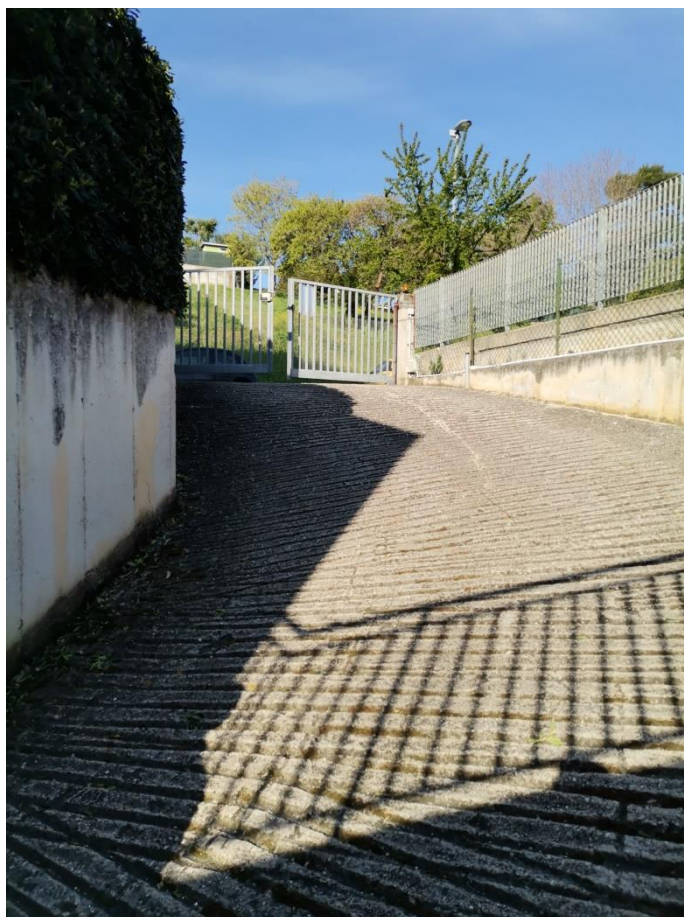
Foto n. 30: Rampa di accesso ai garages
