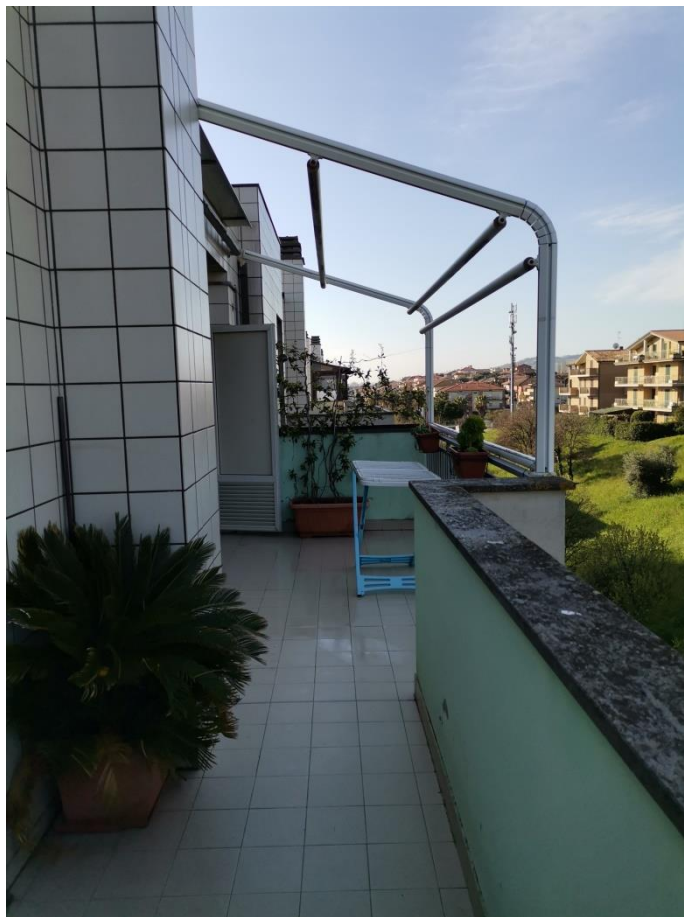
Foto n. 29: Balcone lato ovest
