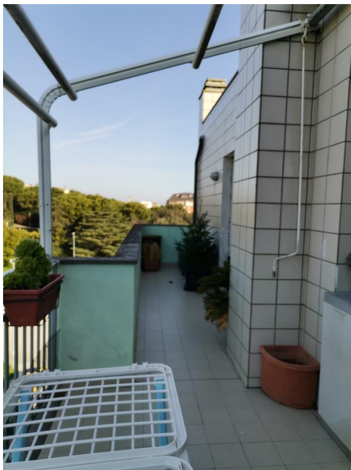
Foto n. 28: Balcone lato ovest
