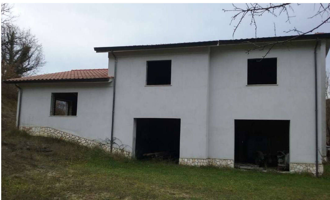
FABBRICATO IN CORSO DI COSTRUZIONE fg 14 p.IIa 738
