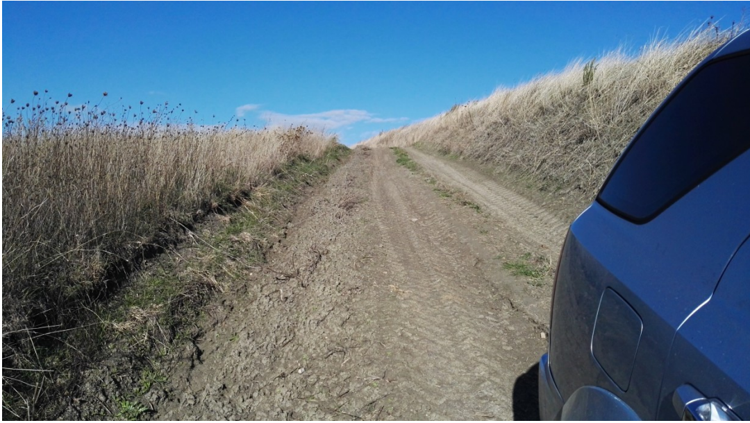
La strada che conduce al lotto 3 foglio 62 p.lla 193
