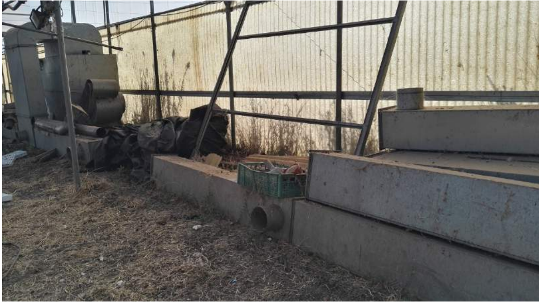
La caldaia non funzionante delle serre
