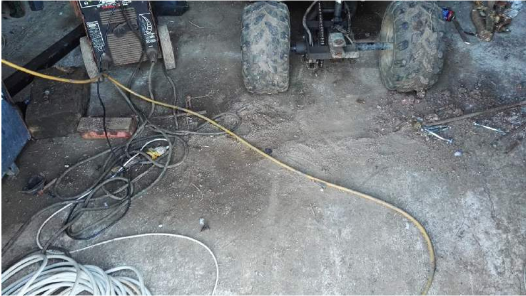
I pavimenti dei sub 7 e 8 del lotto 2
