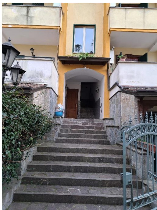
FOTO 5 VISTA DELLA SCALA ESTERNA E DEL PORTONE DI INGRESSO ALL'EDIFICIO ED AL BLOCCO SCALA CHE DISIMPEGNA GLI ALLOGGI AI PIANI SUPERIORI.
