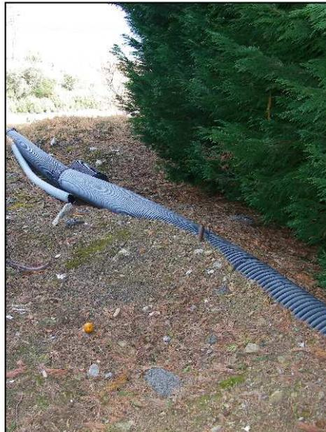
Foto 8. Conduzione di smaltimento delle acque meteoriche portata sopra il livello del terreno a seguito di interventi post frana
