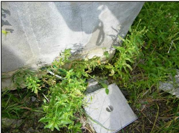
Foto 9. Area del terreno franato sotto il muro di confine
