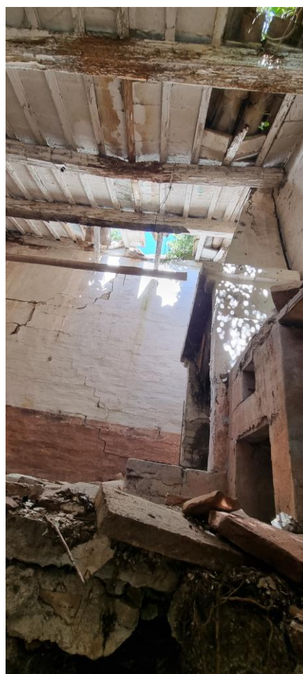
13 – vista del piano primo
