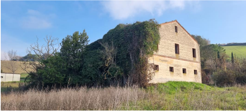
7 – Fabbricato angolo nord ovest
