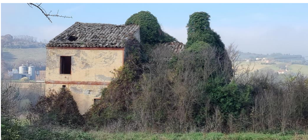
4 – Fabbricato lato sud est
