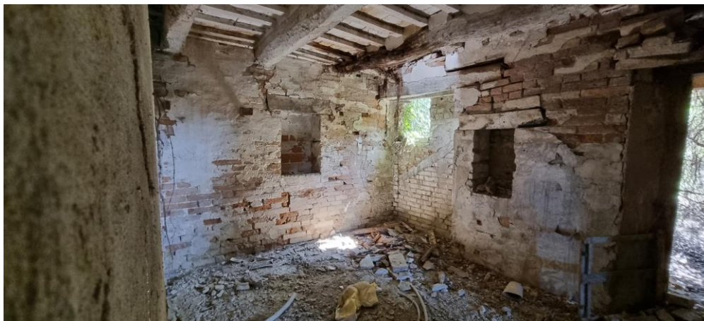
11 – Fabbricato piano terra rimessa deposito
