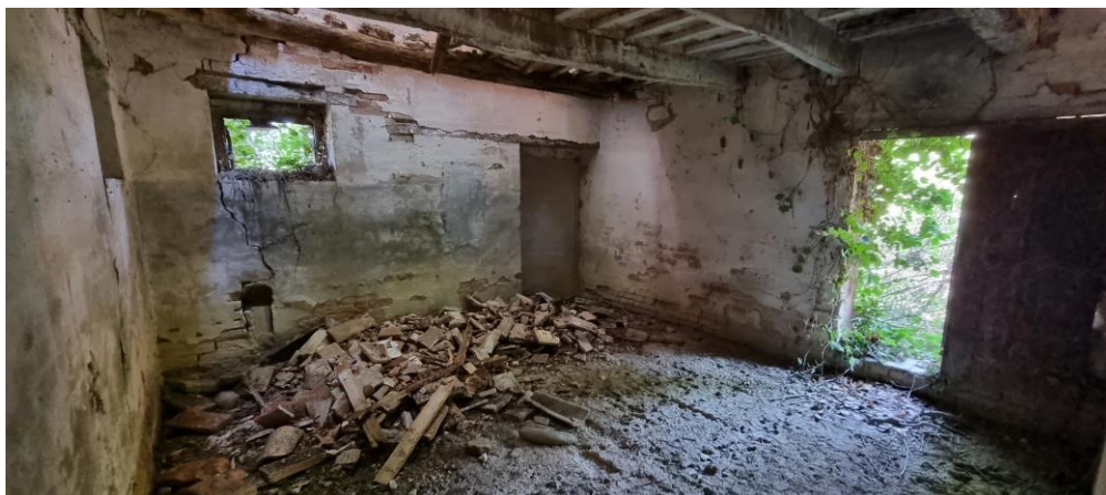
10 – Fabbricato piano terra rimessa deposito
