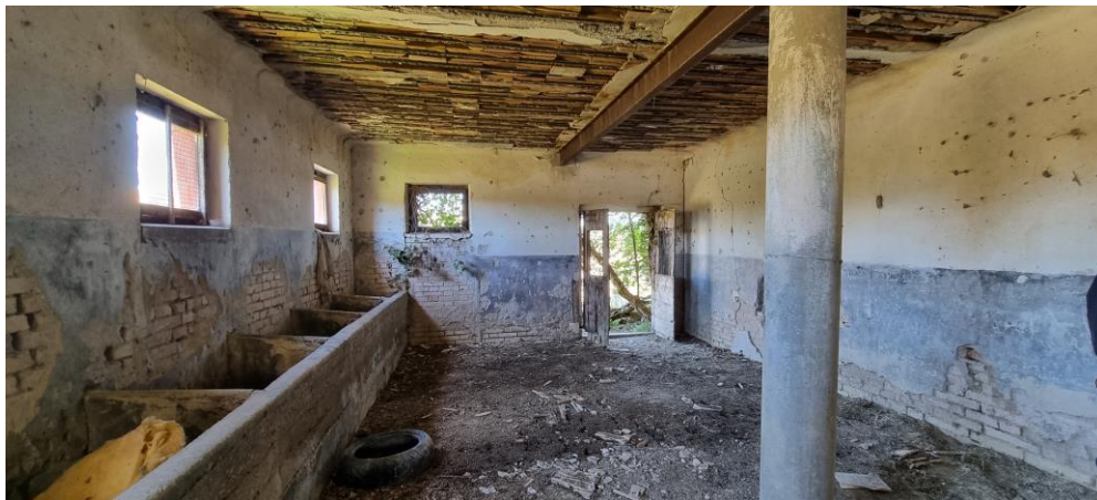
9 – Fabbricato piano terra stalla
