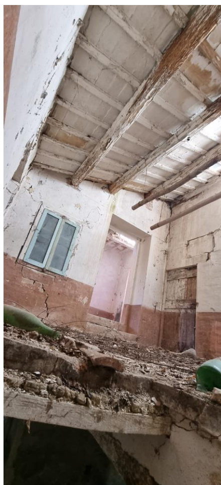
12 – vista del piano primo
