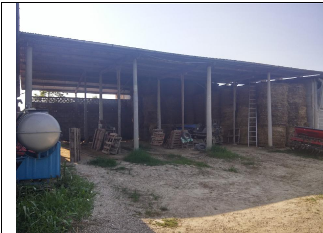
Vista esterna tettoia
