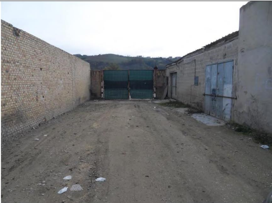
Foto n° 2 – Vista dell'accesso all'area
