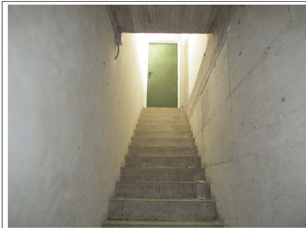
SCALA TRA PIANO S1 E PIANO TERRA
