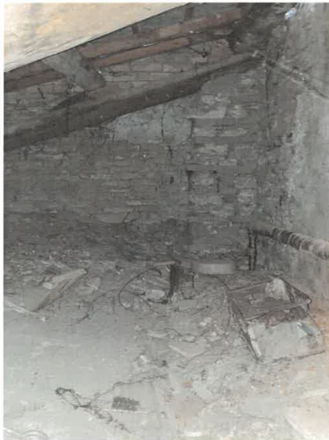
FOTO 16 – Vista interna sottotetto
