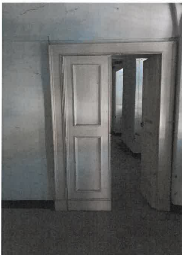
FOTO 12 – Vista interna camera primo piano
