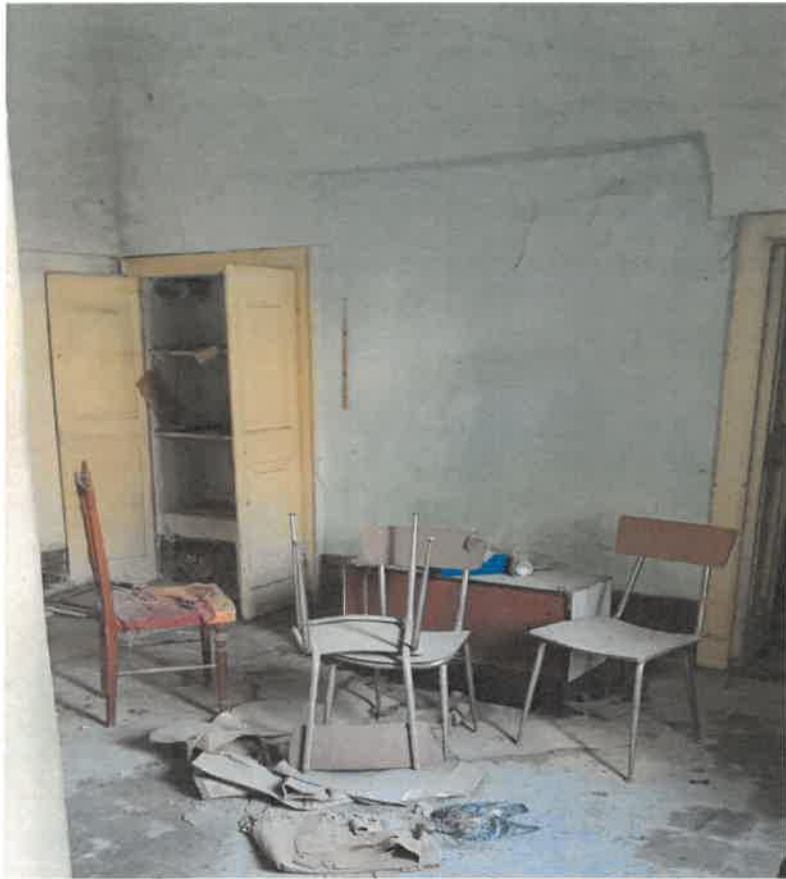
FOTO 7 – Vista interna piano terra
