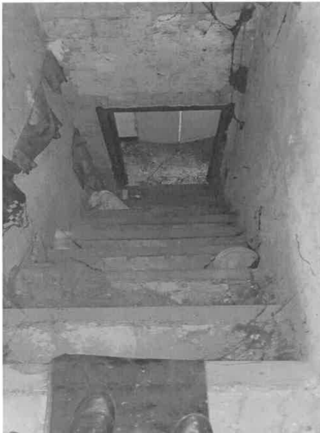
FOTO 14 – Scala accesso piano sottotetto
