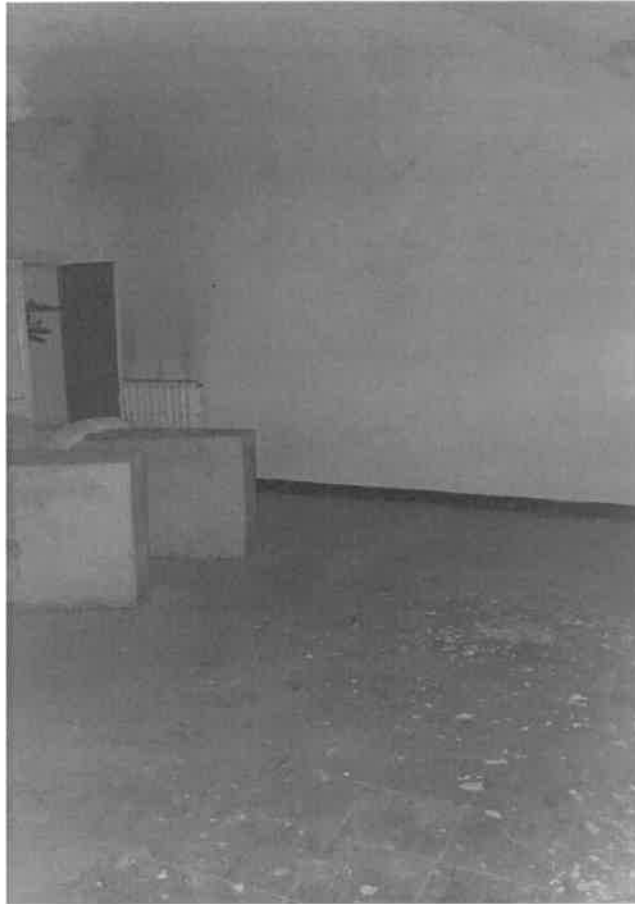
FOTO 13 – Vista interna camera primo piano
