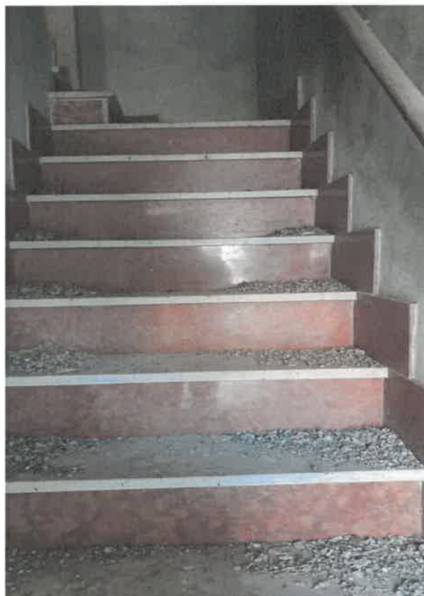
FOTO 10 – Scala accesso primo piano
