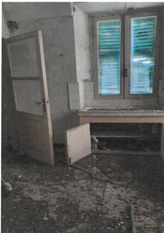
FOTO 11 – Vista interna camera primo piano
