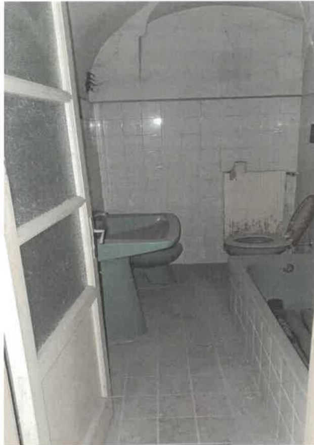
FOTO 9 – Servizio igienico piano terra
