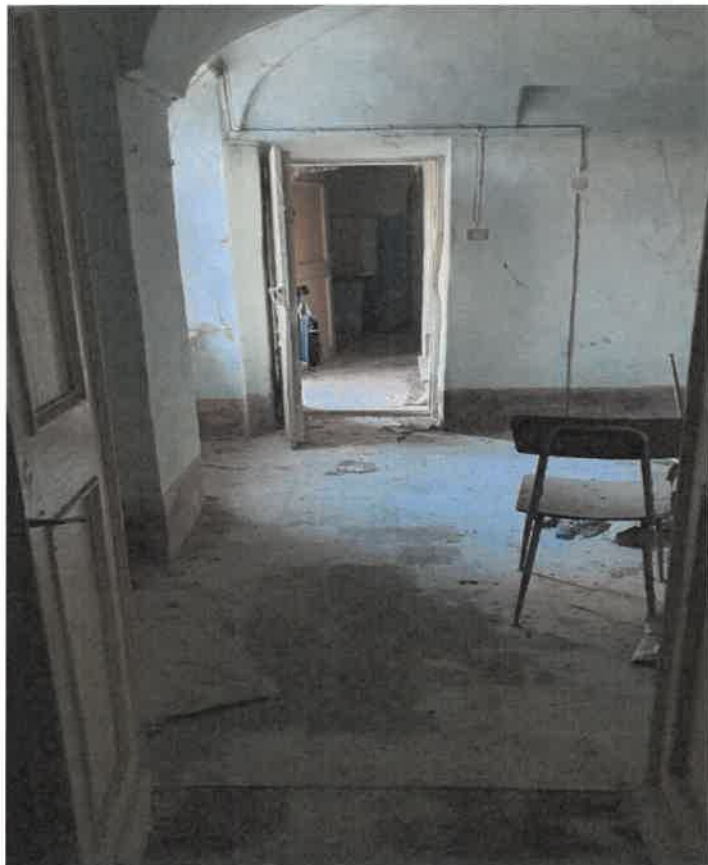
FOTO 8 – Vista interna piano terra
