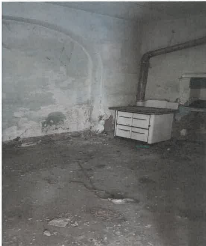
FOTO 6 – Vista interno piano terra
