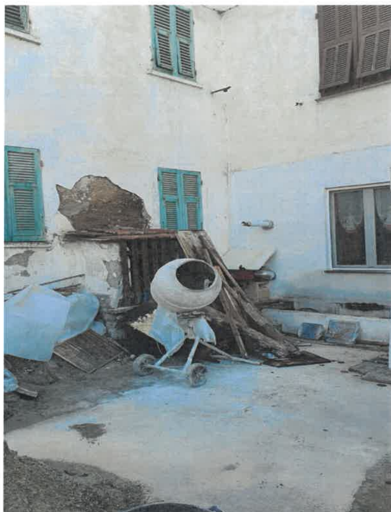
FOTO 3 – Vista pozzo da cortile comune
