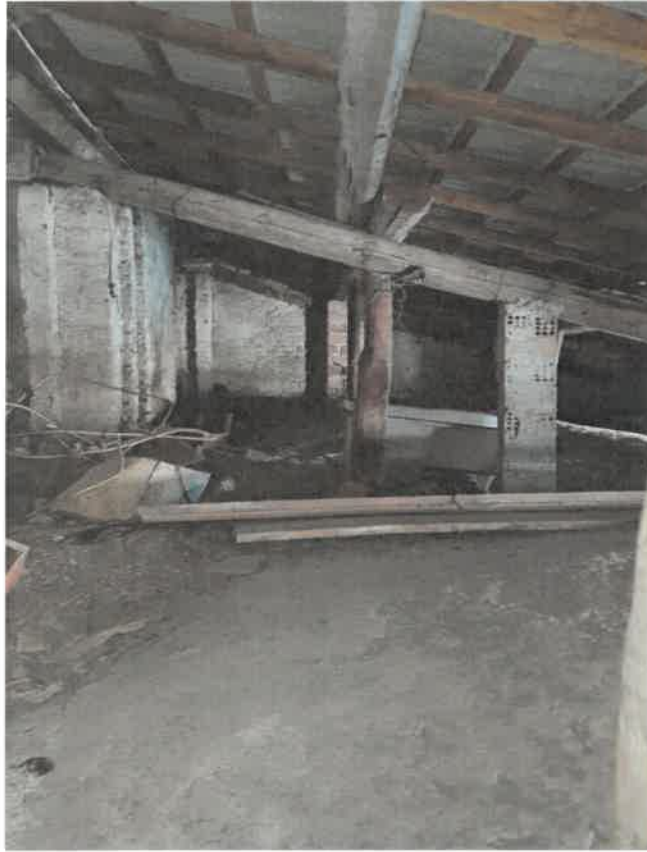
FOTO 15 – Vista interna sottotetto
